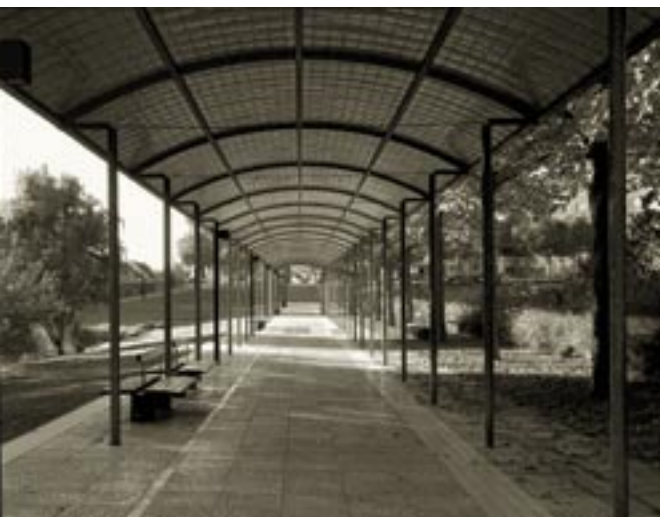
En arrière plan de la promenade des Jours, les façades de la rue Eloi Morel In the background to the Promenade des Jours, the facades of Rue Eloi Morel
