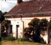
Association de briques, tuffeau, moellons et lameau de Marthelan à proximité de Mouthodun
