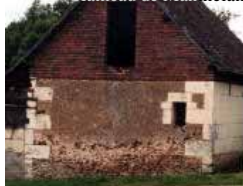
Association de briques, tuffeau, moellons et lameau de Marthelan à proximité de Mouthodun
