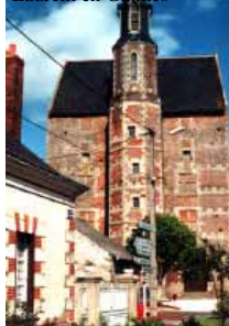
Moellons calcaires et tuiles canal à Preugny sur la commune de Courcoué
