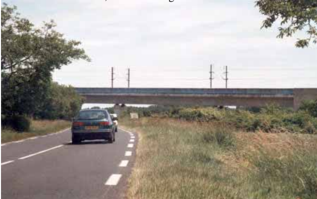
Infrastructures lourdes, lisière tourangelle est
