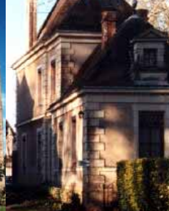
Moellons calcaires et tuiles canal à Preugny sur la commune de Courcoué
