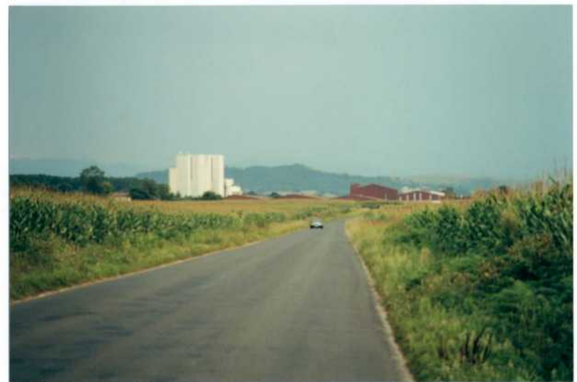
Les bâtiments de Lur Berri à Camou ont une hauteur et une silhouette qui en font un repère dans le paysage
