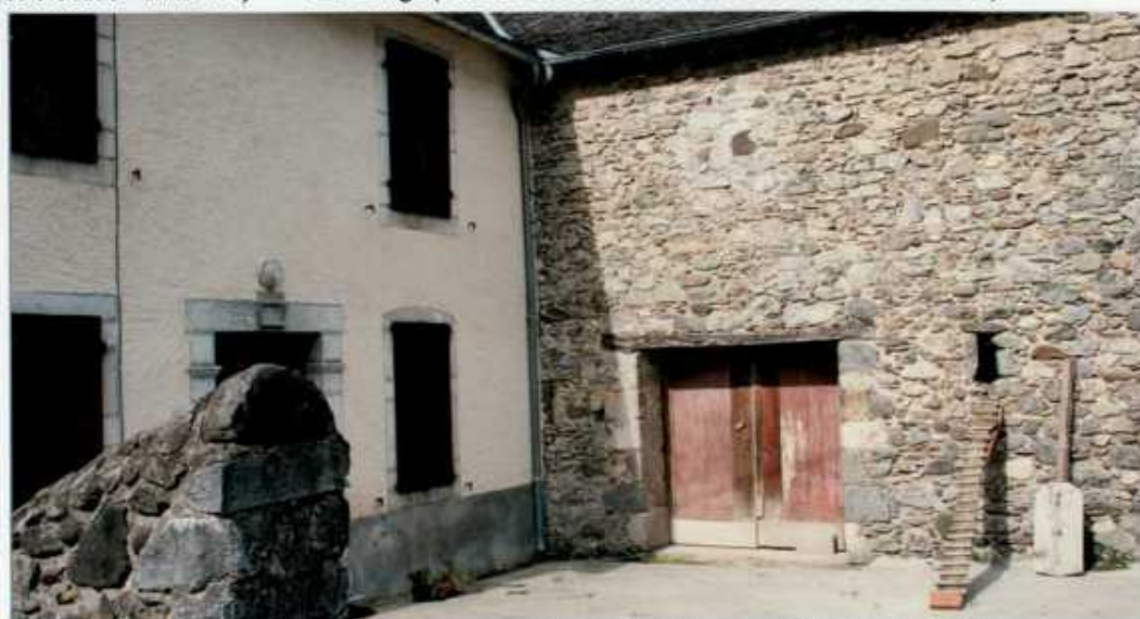
▲ Cour de ferme : habitation crêpie, grange non revêtue (Escot en vallée d'Aspe - unité VA2)
