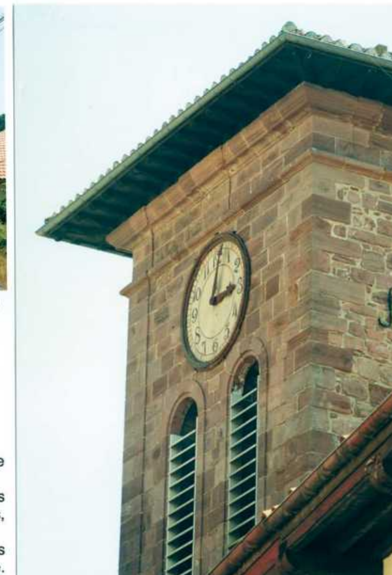
La ville et la citadelle de Saint-Jean-Pied-de-Port, sont en grès rose de la Rhune. Ici le clocher de l'église de Notre Dame du bout du pont (unité HN5)
