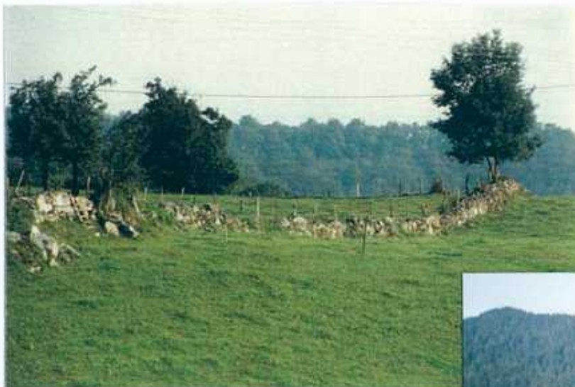
▲ muret de pierres sèches peu entretenu
