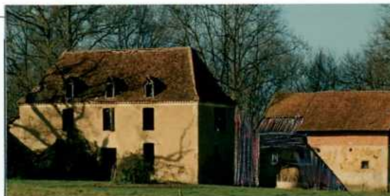
▲ Toits en tuiles picon et murs enduits beige
