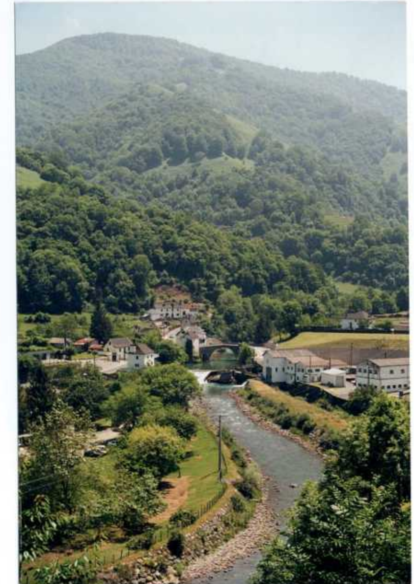
Depuis la rive gauche, le pont des Laminaks à Licq sur le gave du Saison aux berges enrochées. Au dessus du village dans la forêt, on distingue quelques parcelles de landes.
