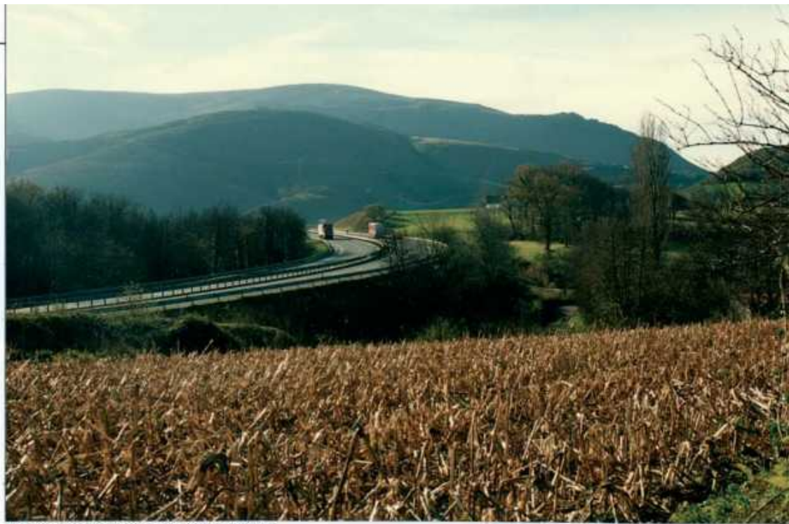
Passage de l'autoroute dans les collines
