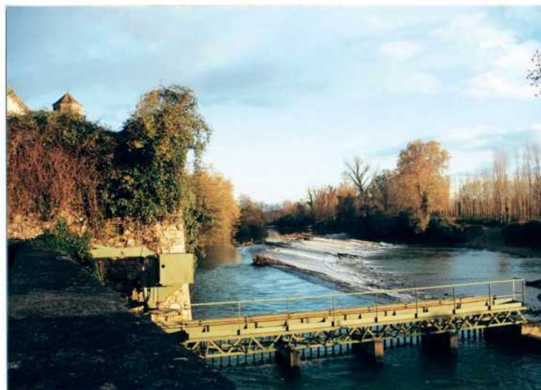
Centrale hydroélectrique à Sorde-l'Abbaye, sur le gave d'Oloron. Peupleraie sur l'île en face
