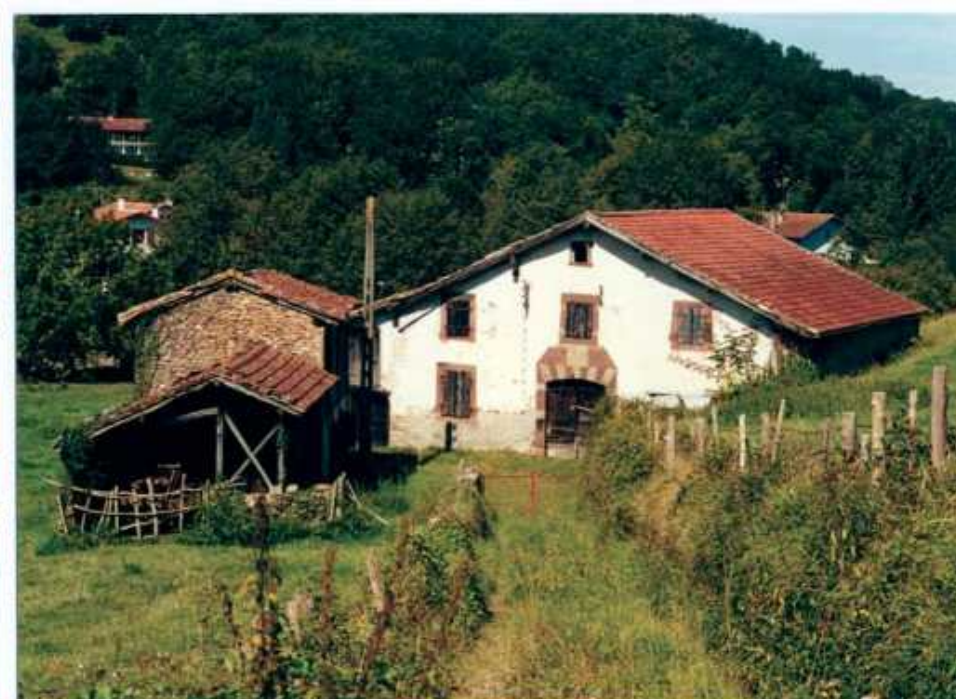
Ferme (abandonnée) dans le bassin de Saint-Jean-Pied-de-Port (unité HN5) où l'on peut voir une particularité locale : "la bouteille" encadrement de pierre qui englobe la porte d'entrée et l'ouverture disposée sur l'axe de symétrie de la façade.
