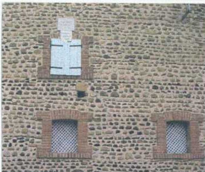
▲ Mur en galets et encadrements en briques (construction 1900)
