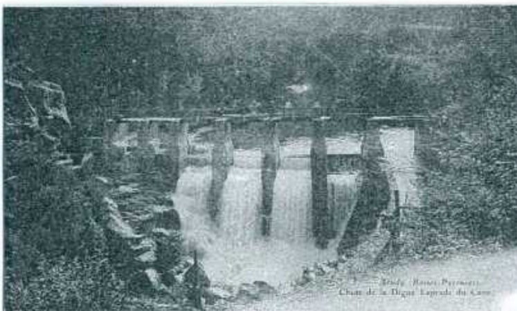
Barrage construit en 1895 pour l'alimentation en électricité d'Arudy
