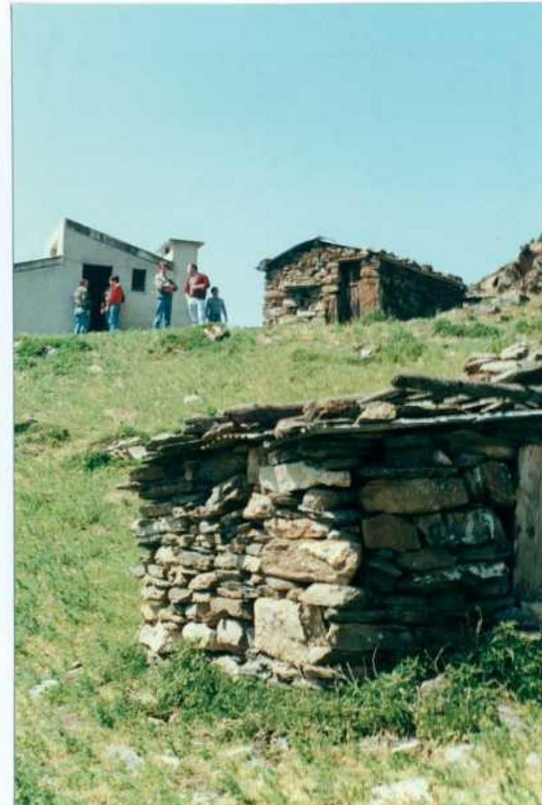
Cabanes anciennes et cabane en béton (années 80), dans le cirque
