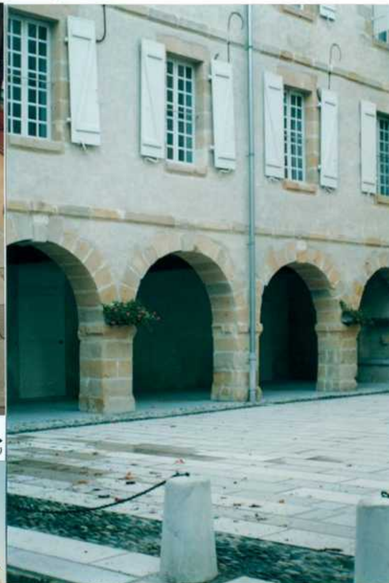
▶ bâtiment et place restaurés (Navarrenx - novembre 1997)
