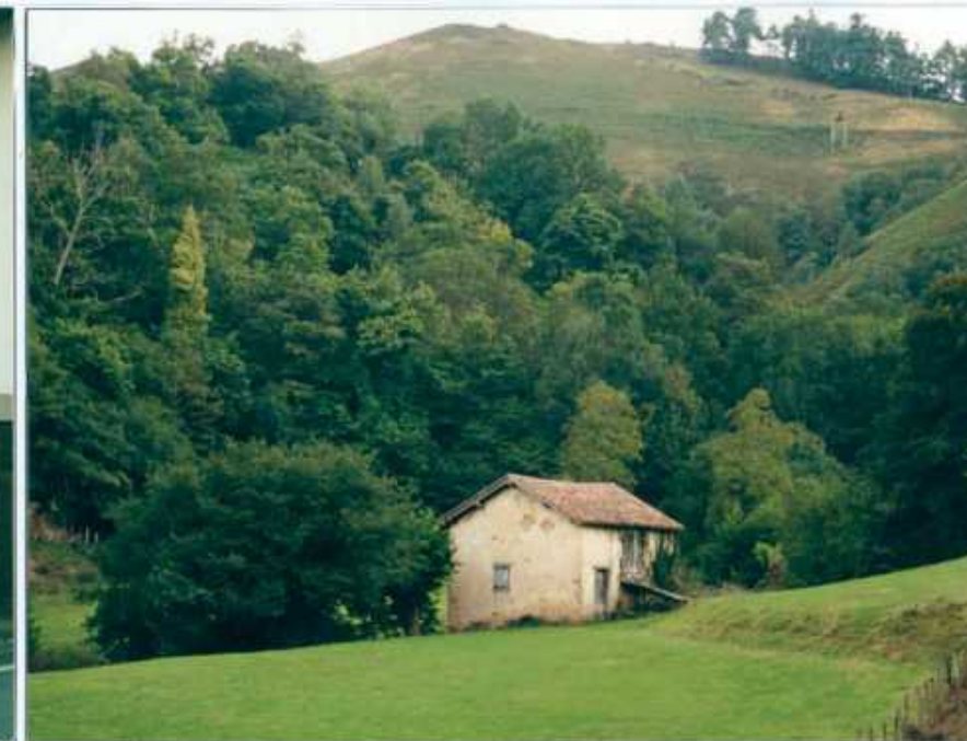
La borde , grange de moyenne altitude (on voit le pan incliné qui donne accès au fenil)
