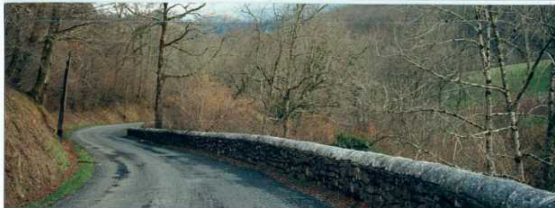
◀ Murs de soutènements en pierres recouverts de mousse et murets garde-corps avec dalles de couronnement en pierres
