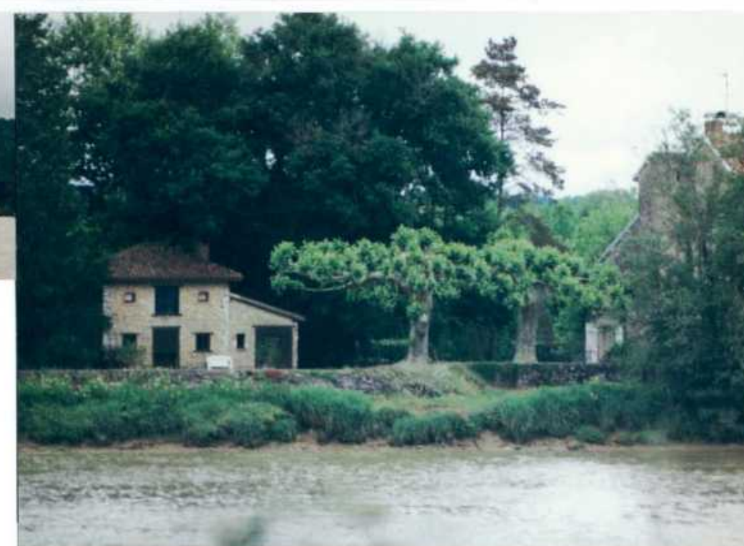
De petits aménagements ponctuels de grande qualité, marqués par la présence de platanes taillés en plateau d'ombrage
