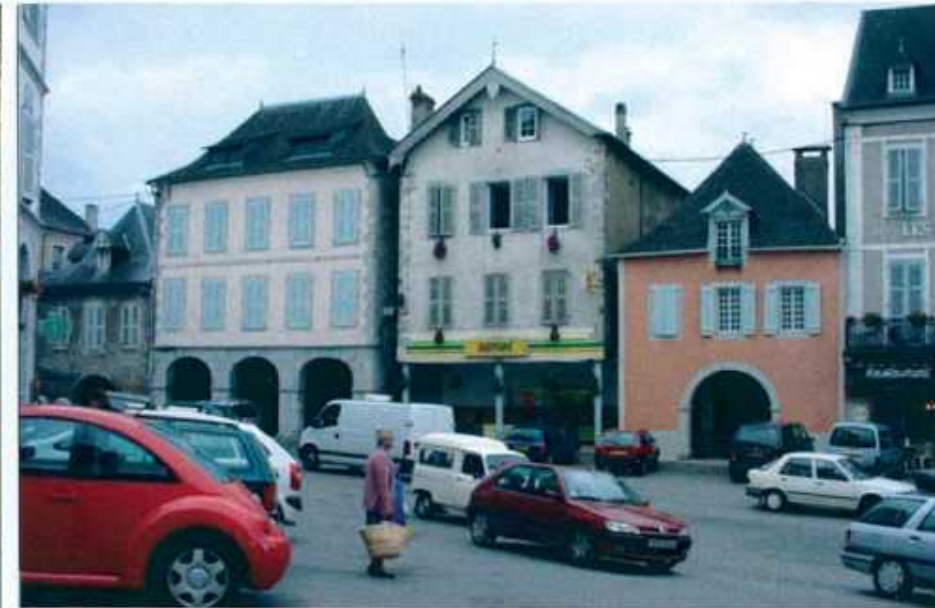
▲ habitat réhabilité en centre ville
