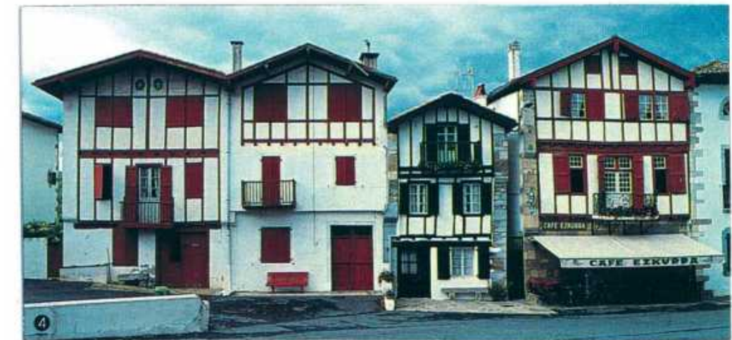
Les façades à colombages des maisons mitoyennes d'Aïnhoa (photo MSM SA)
