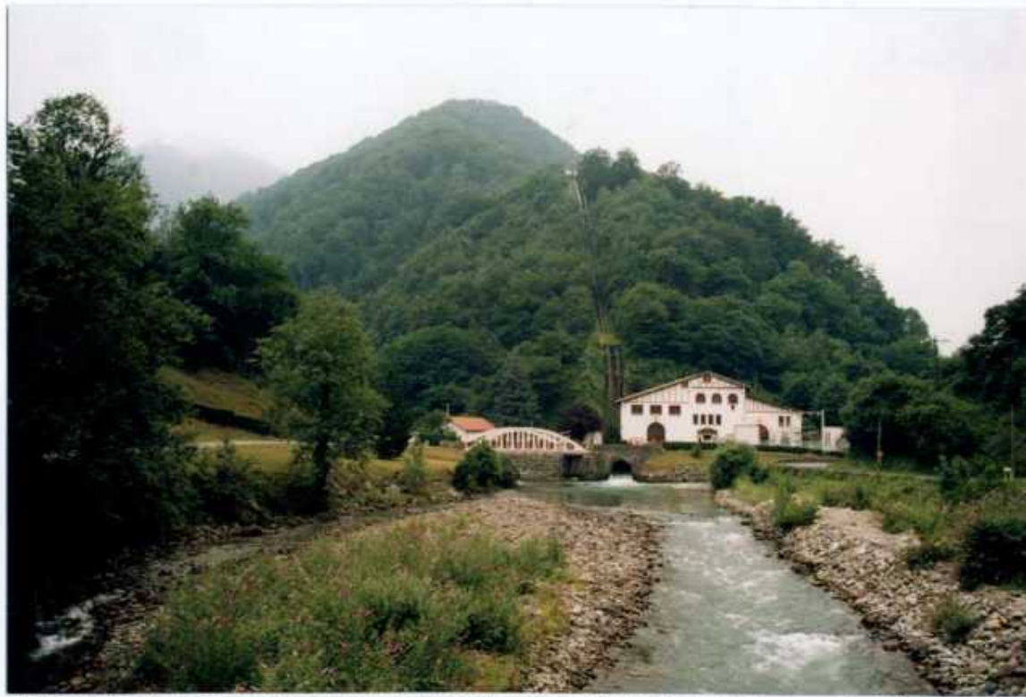
Au Sud, limite de la sous-unité : la centrale hydroélectrique à la confluence des gaves de Larrau et de Ste-Engrâce
