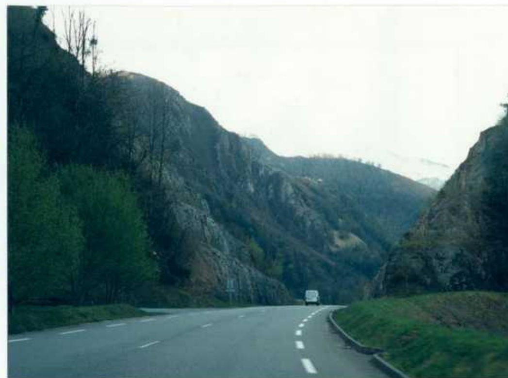
L'élargissement récent de la R.N. au niveau des fontaines d'Escot, a donné lieu à des travaux d'envergure ; l'étroitesse du défilé a été vaincue avec force dynamite ... délaissant l'ancien hôtel d'une station thermale abandonnée (prospère au XIX ème siècle).
