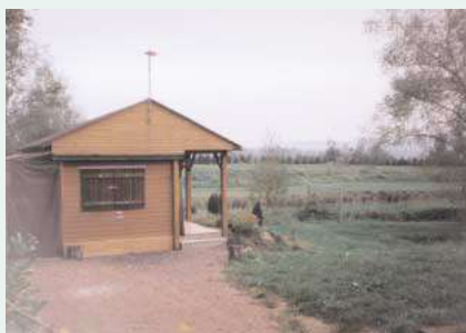
Un cabanon au bord d'un étang La prolifération de l'habitat léger de loisirs est un phénomène qui a tendance à s'intensifier dans certains secteurs
