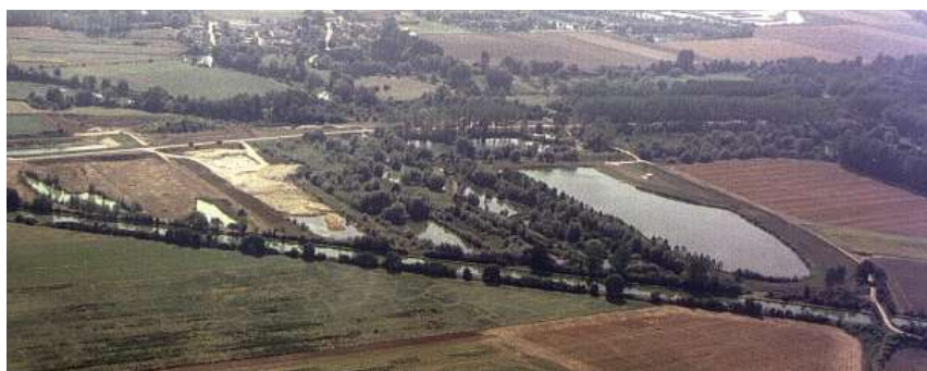
L'exploitation de sable et de granulats
