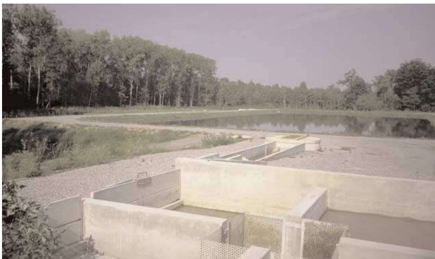
Station de lagunage de Parfondru
