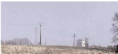
Les réseaux aériens et le chateau d'eau sont dominants dans la mémorisation de ce paysage Panneaux de signalisation et de sécurité.
