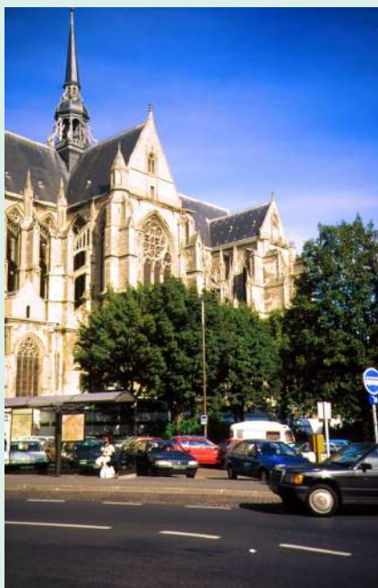
La façade Sud de la Basilique
