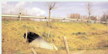
Chivy, passage sous la RN2
