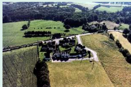
Un lotissement isolé
