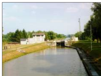
Transports et liaisons fluviaux : écluse de Saint Mard, canal de la Sambre à l'Oise
