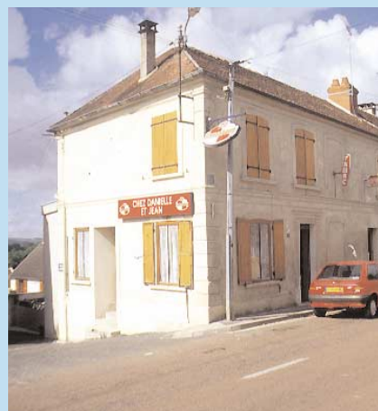
Les enduits au plâtre gros atteignent dans la vallée de la Marne une richesse expressive unique.
