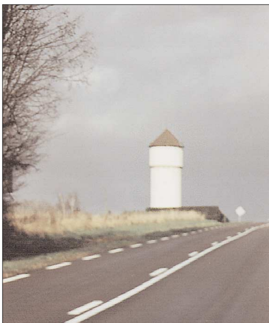
Château d'eau, point de repère dans la Brie.
