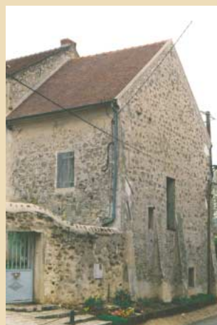
L'architecture villageoise pauvre en modénature doit beaucoup aux qualités plastiques des enduits en plâtres gros.
