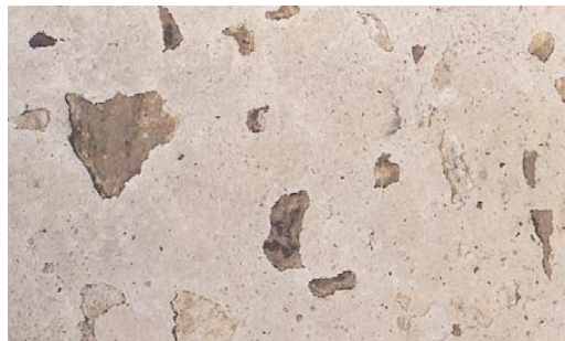
Pierre meulière et enduit à pierre-voie sont une des caractéristiques majeures de l'architecture du Tardenois
