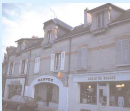
Les configurations systématiques sont discrètement rompues par des détails originaux : les lucarnes, les boutiques, les modénatures...
