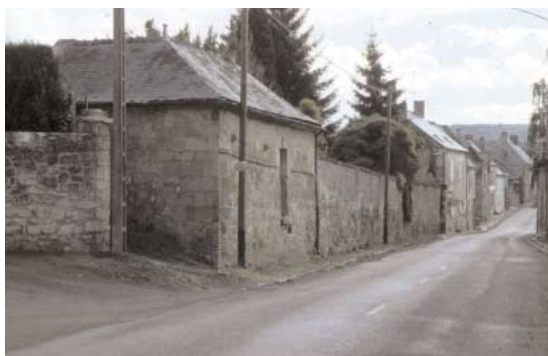
Village de Vivières, rue principale avec bâti aligné sur la voie et prédominance de la pierre
