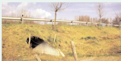
Chivy, passage sous la RN2
