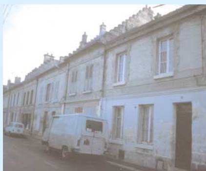
Les constructions modestes ne sont pas dénuées d'un certain charme ne serait-ce que pour la qualité des matériaux en élévation.
