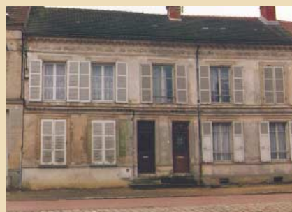
Les typologies urbaines façonnent des espaces minéraux denses rythmés par les baies et les modénatures élaborées
