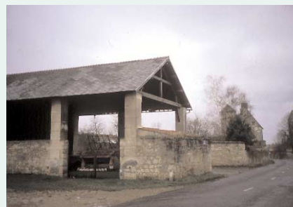
Hangar agricole dans le village de Largny
