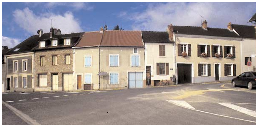
La variété des techniques constructives permet d'animer les volumes denses des constructions urbaines
