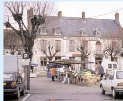
Les façades bourgeoises rythmées par de nombreuses baies, définissent de vastes espaces publics qui rappellent le passé commercial de première importance locale de la ville.
