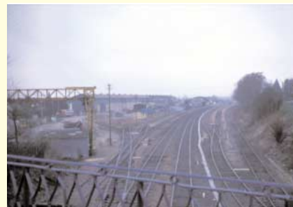
Dans les vallées qui découpent le plateau, s'installent les infrastructures telles les voies ferroviaires
