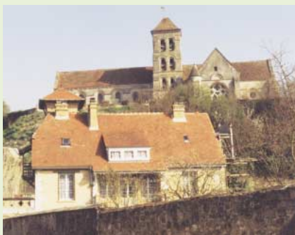
A l'inverse, depuis les voies menant au village, la silhouette de l'église se détache sur le ciel, telle un phare dans le paysage
