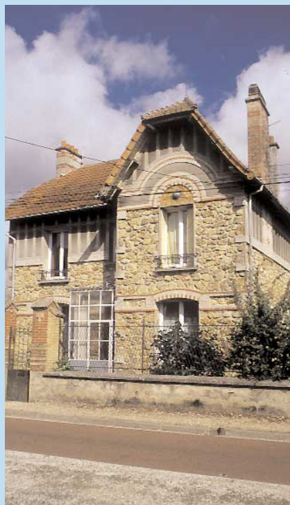
La modénature élaborée et parfois fantaisiste des bâtiments de la reconstruction rompent avec la rigueur de l'architecture traditionnelle de la vallée de la Marne .
