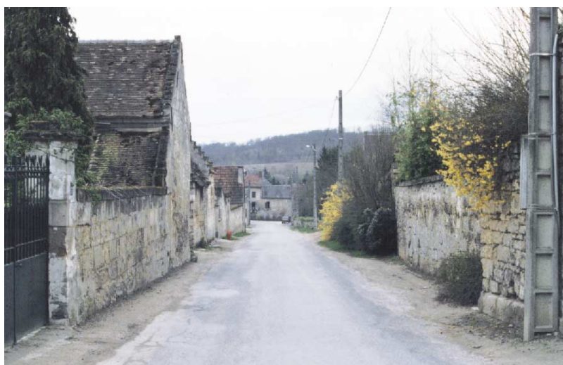
Les murs de clôtures, très présents dans le Soissonnais, donnent une densité aux fronts bâtis en assurant aux espaces publics une homogénéité d'une grande qualité. (Septmonts)
