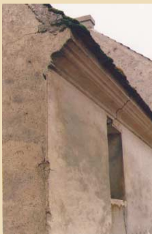
Les modénatures "tirées" propres aux architectures de la Brie. Cette technique fait appel un savoir-faire unique tombé en oubli au préjudice du patrimoine brillard.
