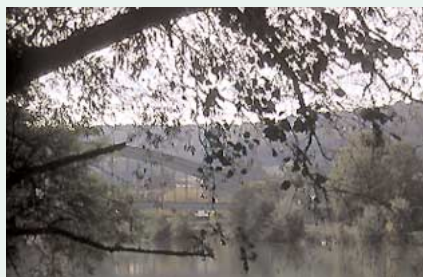
Pont de Jaulgonne sur la Marne
