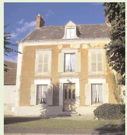
Les enduits au plâtre gros sont l'exclusivité du Tardenois et de la Brie
