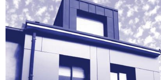
Aperçu d'une rénovation d'habitat ouvrier
