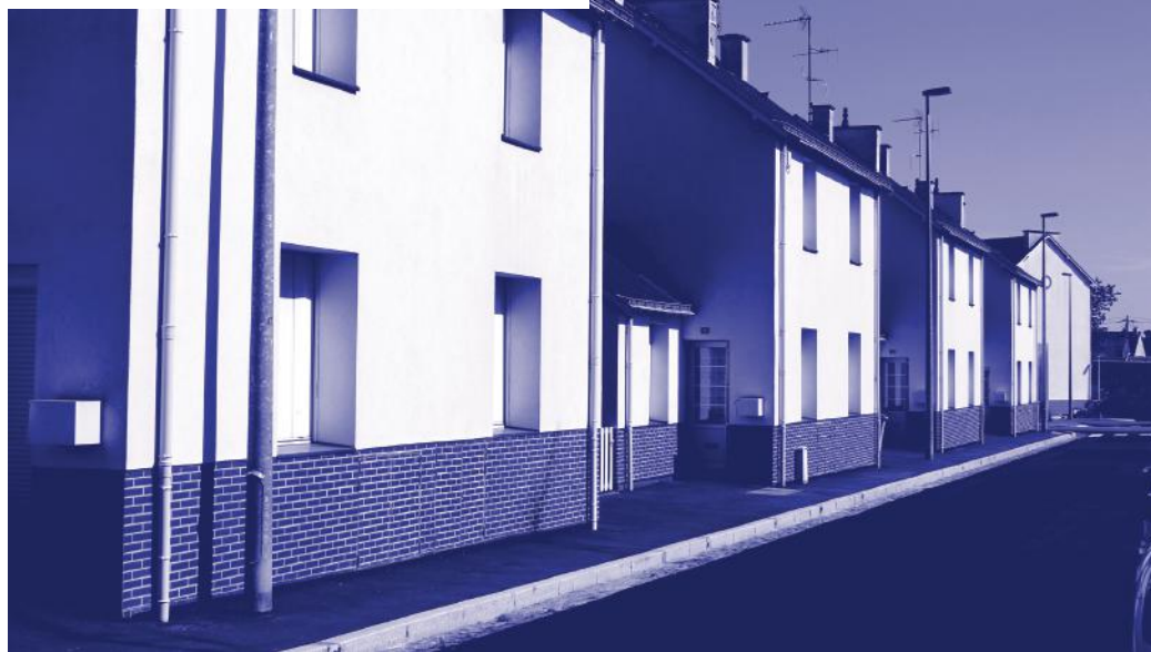
La rue de Monastir, une réhabilitation en décalage avec le passé
