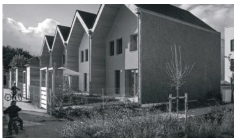
Eco-quartier des Noés, Val-de-Reuil, atelier Philippe - Madec et Plages Arrière (urbanisme & architecture)
