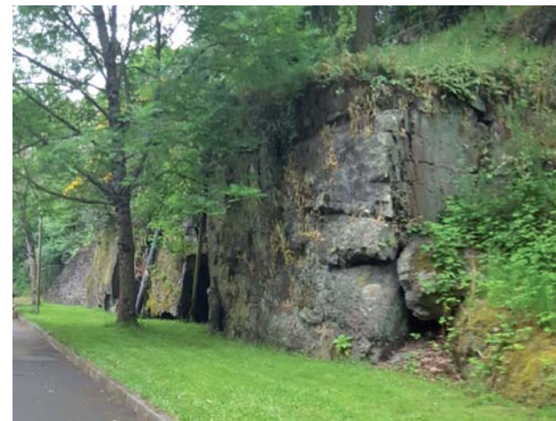
Front de taille - emprise Lycée maritime
