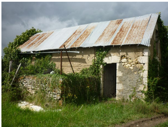
Des éléments du bâti rural à prendre en compte.
