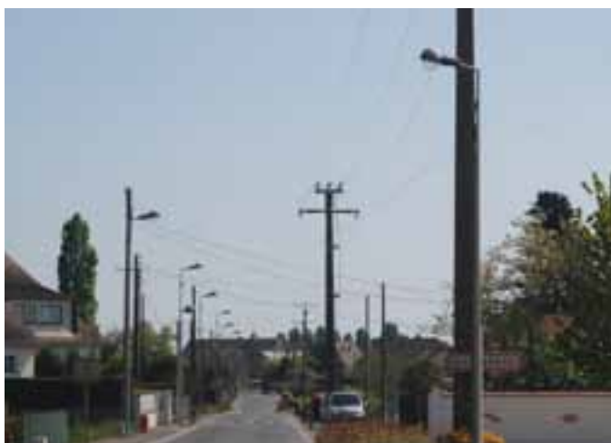
Entrée de Villebarou marquée par les réseaux aériens
