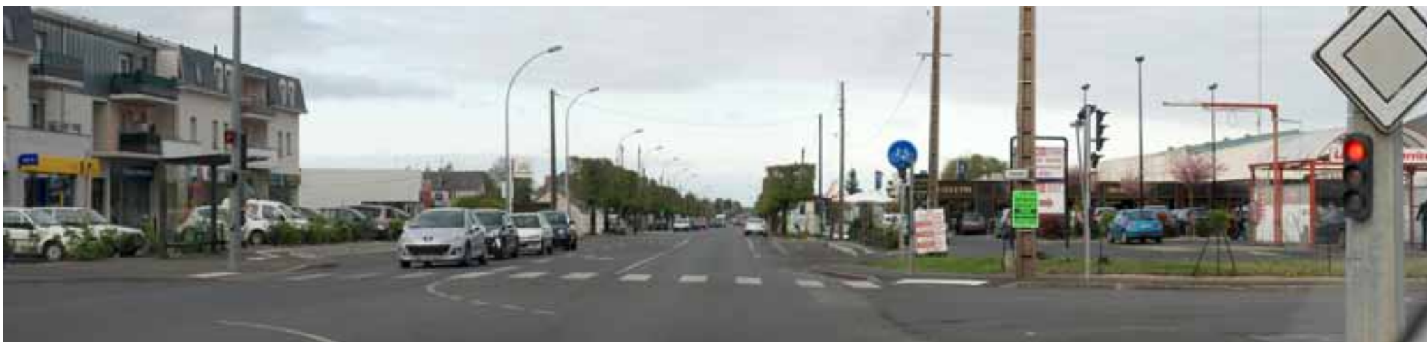
Aspect routier de l'entrée de ville de Blois à la Chaussée Saint-Victor (RD2152)
