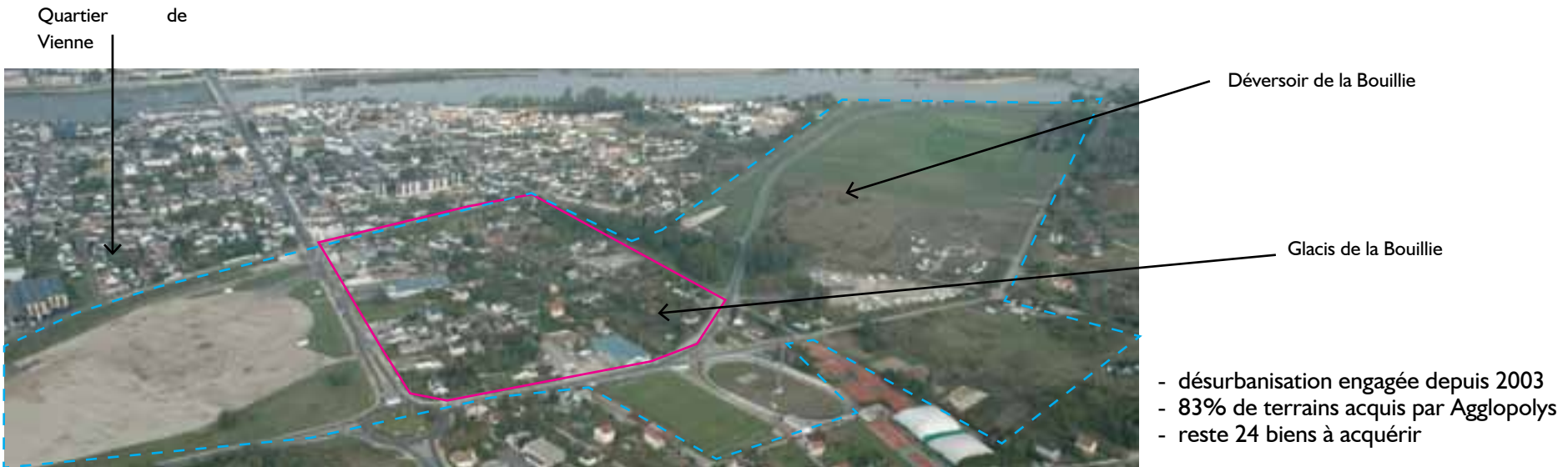
Vue aérienne du Glacis et du Déversoir de la Bouillie : une continuité hydraulique en voie de reconquête
