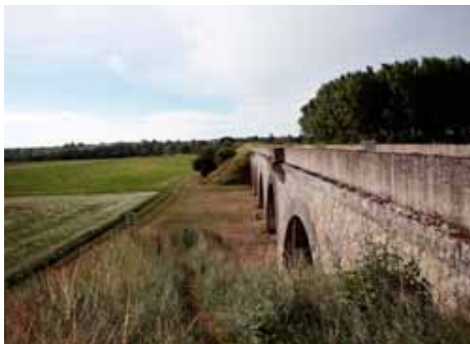
La perspective du viaduc qui souligne la largeur de la vallée
