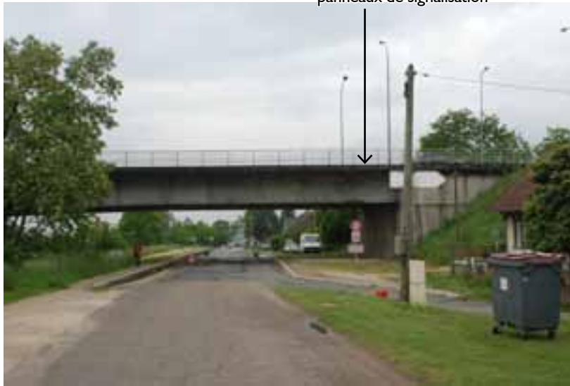
Le chemin d'accès peu valorisant du Parc des Mées
