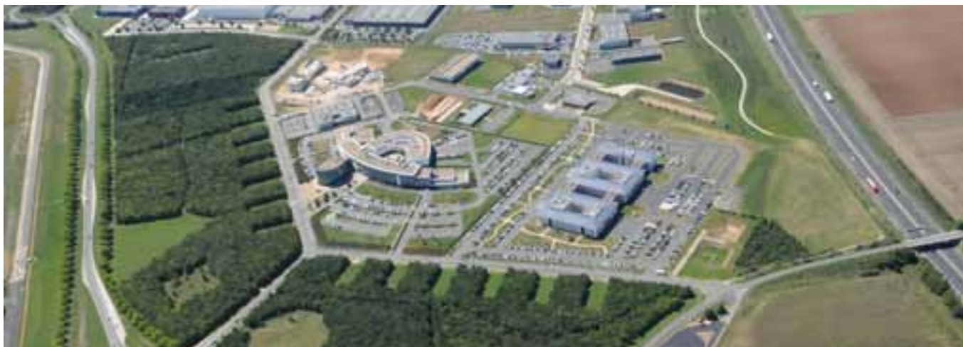
Vue d'ensemble de la nouvelle forêt et des bâtiments d'activité , Parc A10, La Chaussée-Saint-Victor
