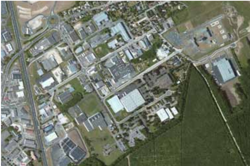
ZAC des Sablons, Vineuil, addition d'emprises excessivement minéralisées
