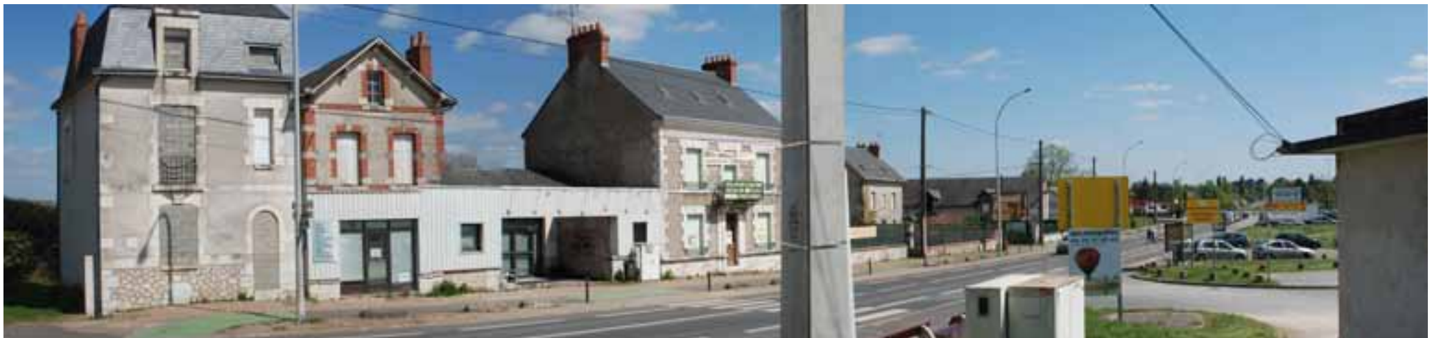
Déconstruction en cours à Blois Vienne pour la reconquête du Déversoir de la Boullie
