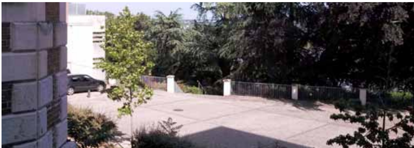
Des ouvertures bouchées sur le grand paysage de la Loire, depuis le quartier de la Chocolaterie
