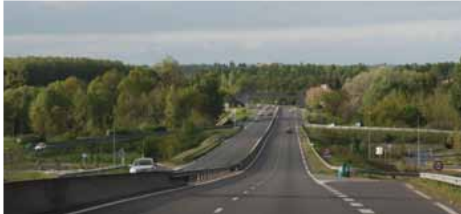
Un franchissement de coteau et une ouverture sur la Loire à remettre en scène : depuis la rocade, RD 174, Vineuil
