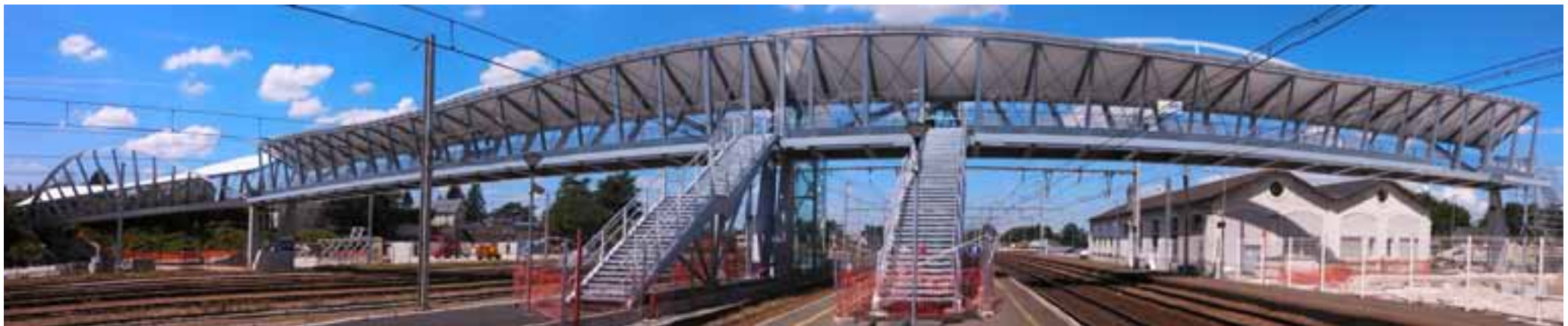
La nouvelle passerelle piétonne et cyclable au-dessus des voies ferrées : une manière de réduire la coupure des emprises ferroviaires en ville
