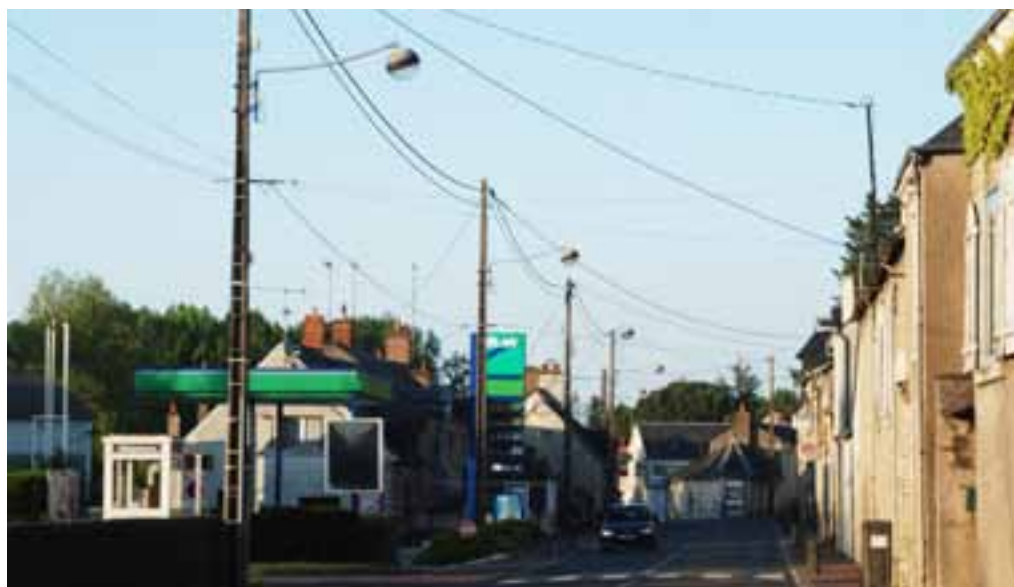
La RD 751 à Chailles, problème de réseaux aériens envahissants
