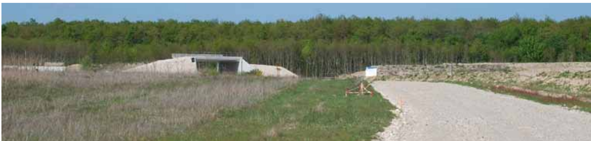
Le chantier de la déviation de Cellettes, non loin du château de Bousseuil - avril 2014
