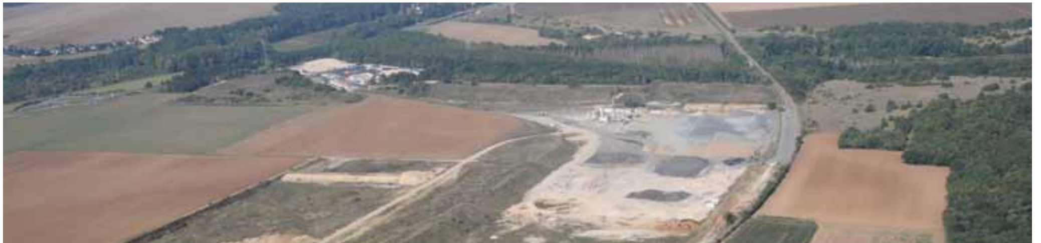
Anciennes carrières devenues une déchetterie et une centrale d'enrobé à l'ouest de Marolles, impact sur la végétation de la réserve de Grand'Pierre et Vitain
