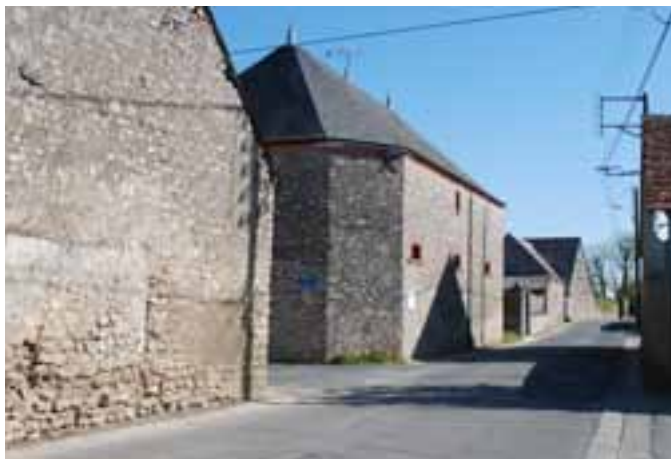
Une ferme et ses beaux murs de pierre calcaire, à Jarday, commune de Villerbon
