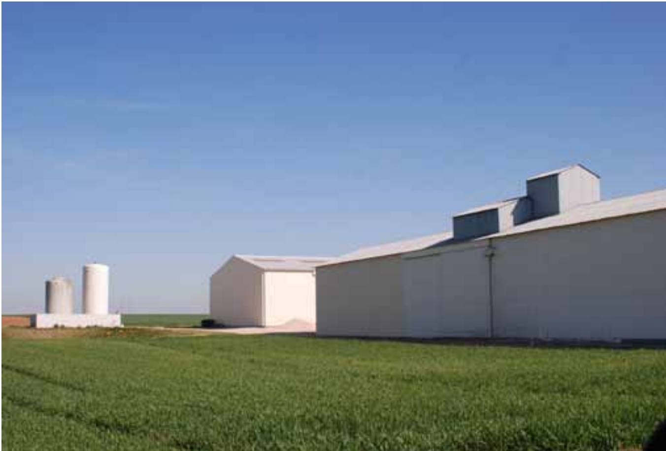
Cas de bâtiments agricoles trop blancs et dépourvus d'accompagnement végétal d'essences indigènes ; Villesecron, commune de Villerbon
