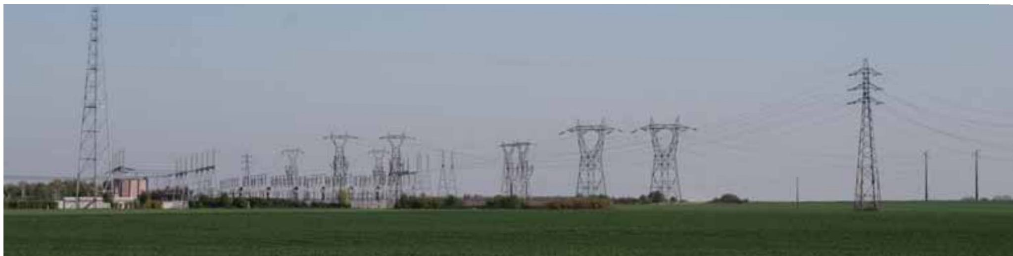
Poste électrique de Villerbon/Marolles
