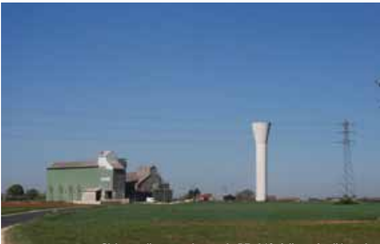
Château d'eau et silos sur le RD 162, à l'entrée d'Averdon
