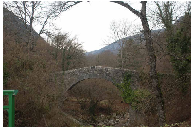
Pont sur le Loup entre Cipières et Gréolières
