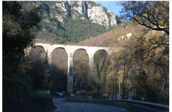
Viaduc ferroviaire au Bar-sur-Loup
