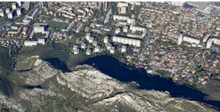
Contraste des formes urbaines et perméabilité, Saint-Loup, la Valbarelle, Marseille – Source : @ P.BLOT photographe, 2014
