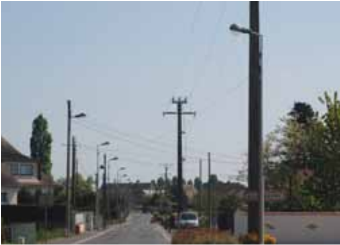
Entrée de Villebarou marquée par les réseaux aériens
