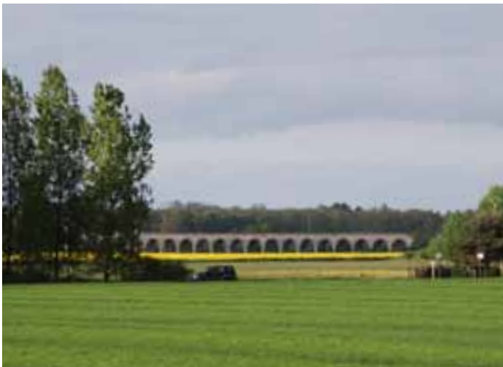
Ancien viaduc ferroviaire de Vineuil
