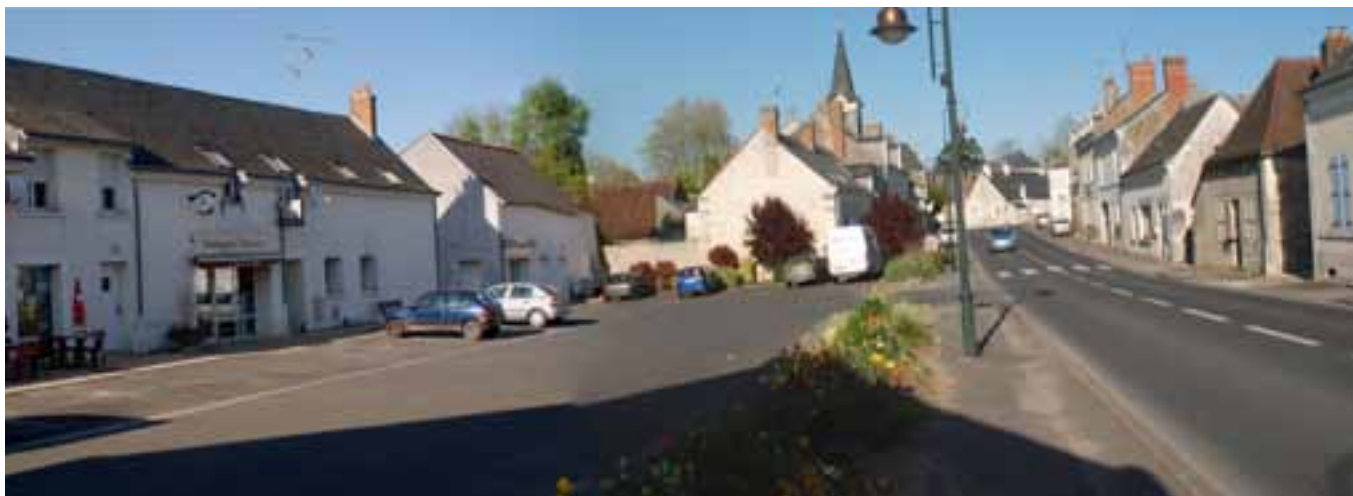
Le cas d'espace public en centre-bourg suivant des dispositions routières nuisibles; Sambin, RD 764
