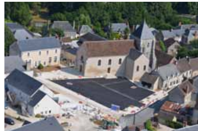
Le coeur de Landes-le-Gaulois en cours de réaménagement
