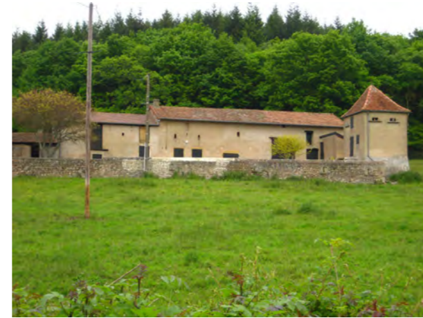
Ancienne ferme à Curtil-sous-Bufferières
