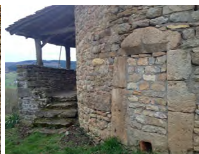
Bouchage d'une baie à Sigy-le-Chatel
