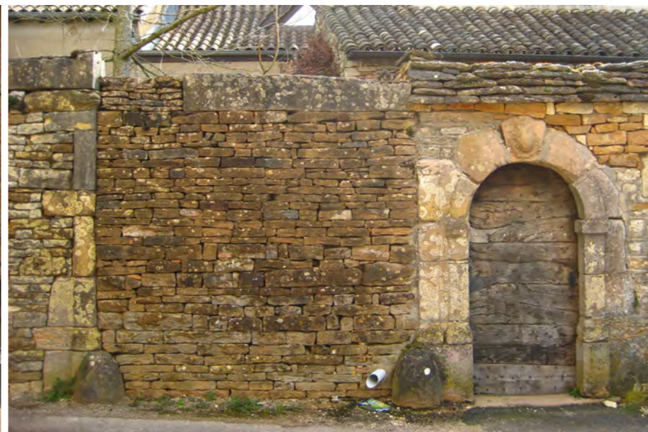
Maçonneries recomposées d'un ancien portail à Clessé
