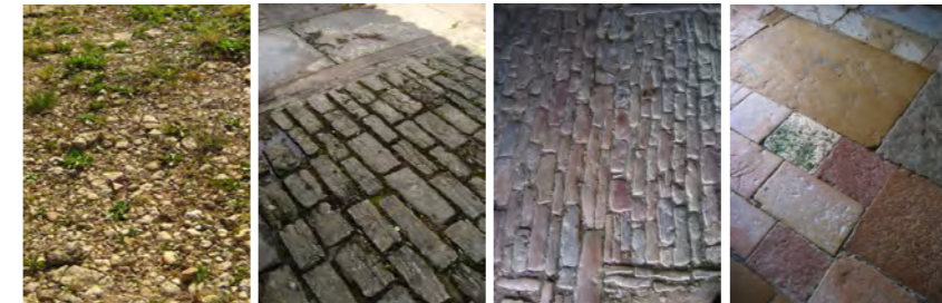
Calades, pavages, dalage, la pierre au sol
