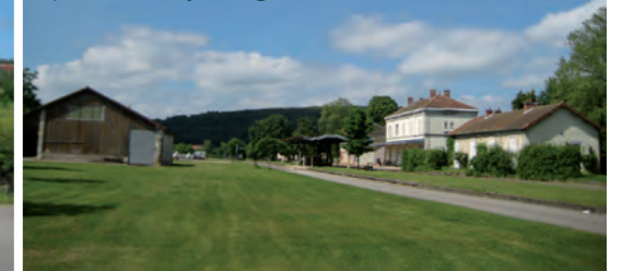
Ancienne gare de St Gengoux le National aujourd'hui passage de la voie verte.
