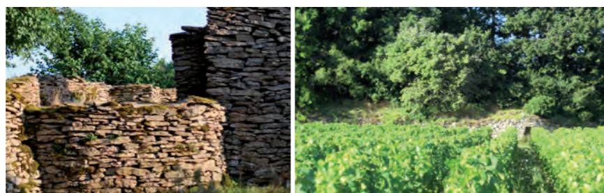
Exemple de cadoles à Donzy-le-Perthuis et à Bonnay Abris pour les ouvriers viticoles, ces constructions en pierre sèches ponctuent le territoire. Elles appartiennent très souvent aux murs ou sont comprises dans les murgers.
