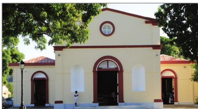
Figure 100 : Eglise de Saint-Louis (Source : CAUE 971)
