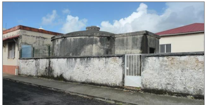
Figure 31 : Citerne dans le bourg (Source : Tropisme)
