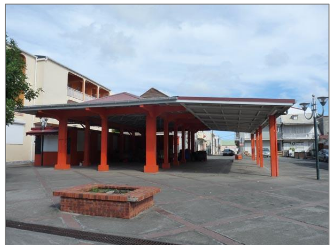
Figure 96 : Marché couvert (Source : Tropisme)
