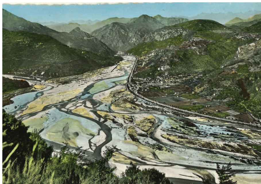
BEC DE L'ESTÉRON AVANT L'ENDIGUEMENT RIVE DROITE
