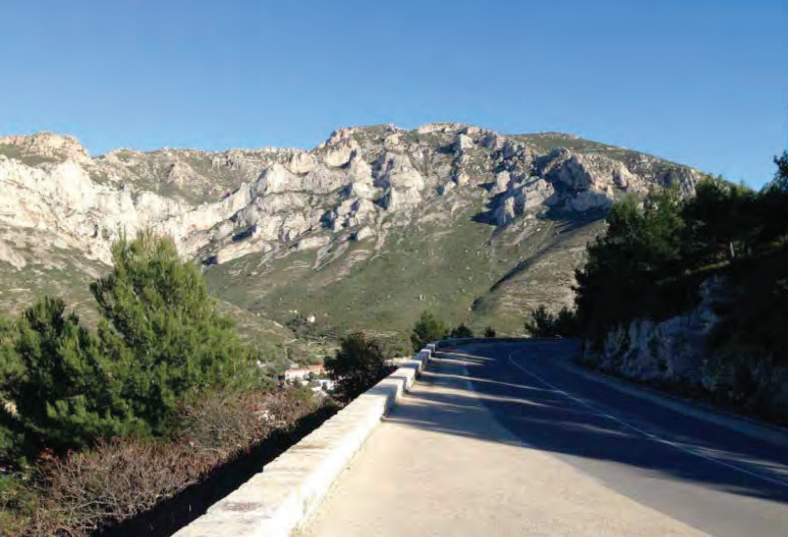
Route de la Gineste, arrivée vers Marseille (photo S.BOSC)
