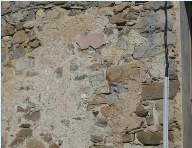
*La diversité des pierres de construction apparaît sous l'enduit usé*
