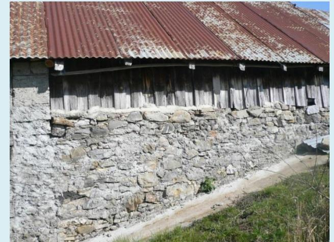
*Maçonnerie de pierre pour le mur, pans de bois ventilés pour la grange sous toiture, la tôle ondulée a remplacé la couverture ancienne.*
