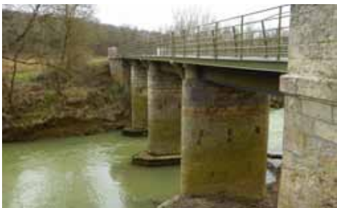
Pont à structure mixte, pierre et métal. Le garde-corps a été rénové dans le respect du style d'origine. Pergain-Taillac
