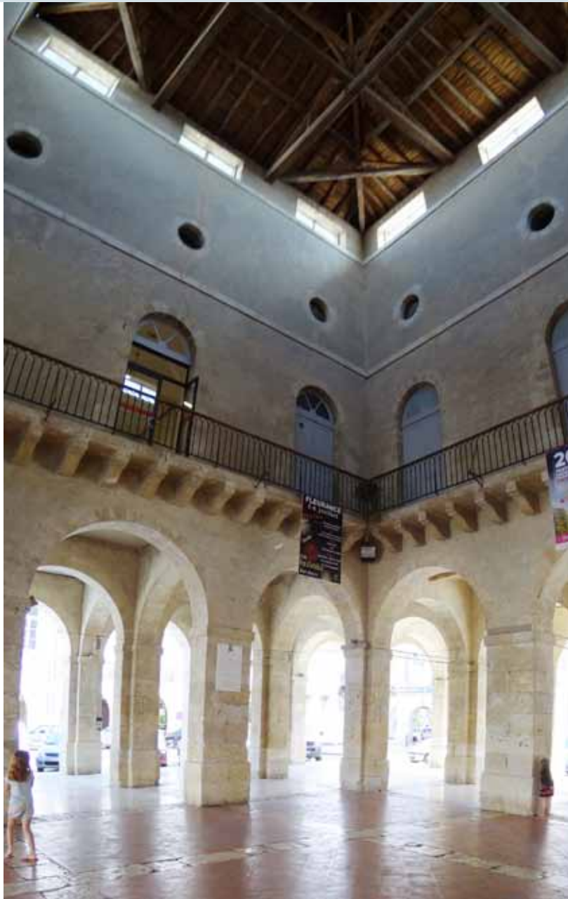
88 Sur la place centrale, la halle-mairie a été édifée en 1837, remplaçant la maison commune dévastée par un incendie. Fleurance
