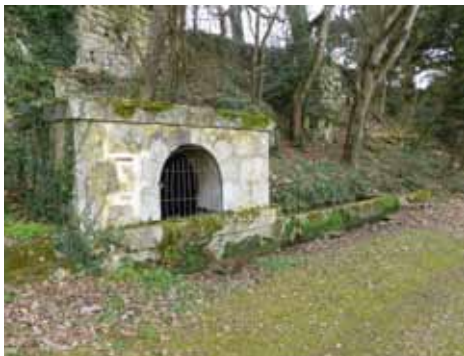
L'eau affleure au niveau des bancs calcaires. Sources, fontaines et puits ponctuent ce paysage en apparence sec. Saint-Martin-de-Goyne
