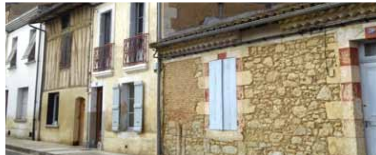
Elégante façade sur rue avec maçonnerie enduite et façade latérale plus rustique à ossature bois et remplissage en terre. Fleurance
