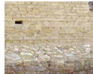
Briques de terre crue sur soubassement de pierre. Fleurance
