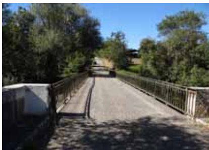
Le passage sur le pont est souvent la seule façon d'apercevoir le cours d'eau. Castéra-Lectourois
