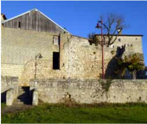
Front de l'ancien rempart encore lisible dans la structure du bâti réutilisé. Sempesserre
