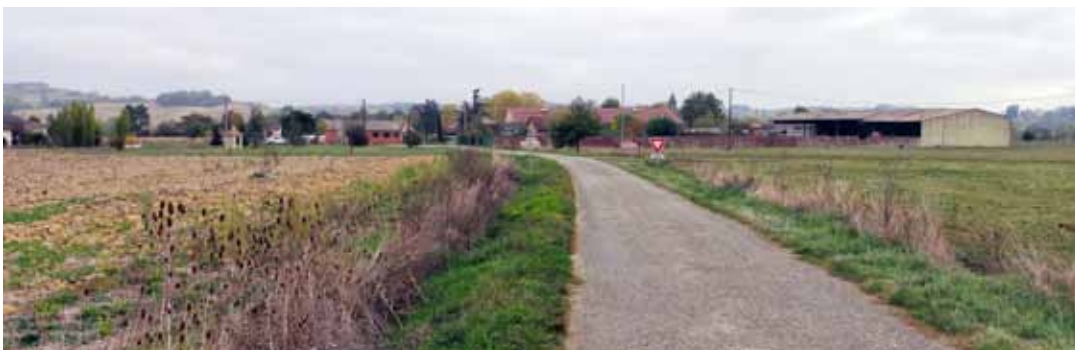
La silhouette de Peyrecave, implanté en fond de la vallée de l'Arrats, ne se découvre qu'au dernier moment. Peyrecave
