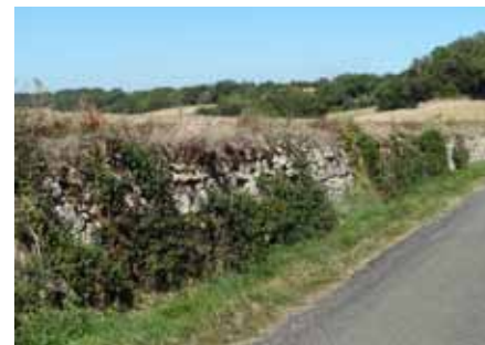
Le calcaire apparaît également dans les murs de soutènement ou de clôture qui longent les voies. Castéra-Lectourois
