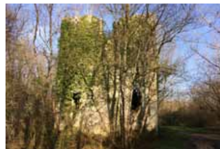
Moulin de la Mothe à proximité du pont barrage sur le Gers. Lectoure
