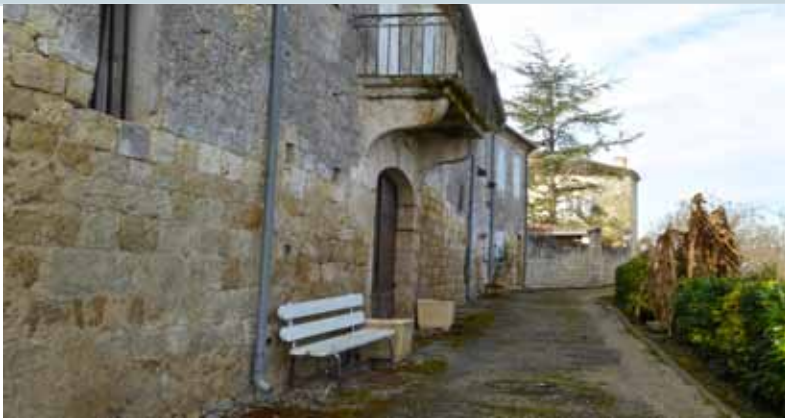
Les remparts côté nord offrent une vue sur les environs. Terraube
