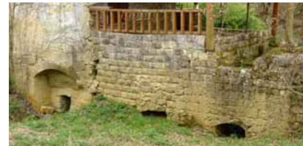
Comblement progressif des anciens passages d'eau du moulin près de l'Ourtiguet. Sempesserre
