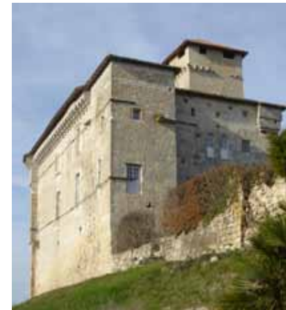
L'imposante façade du château de Plieux
