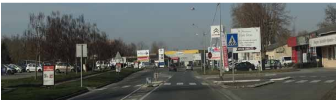
Les zones d'activités impactent fortement le paysage de la vallée du Gers le long de la RN21. Fleurance
