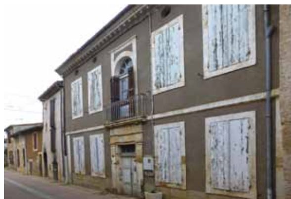
Maison avec modénature en pierre de taille sur travée centrale, avec baie cintrée et balcon. Flamarens
