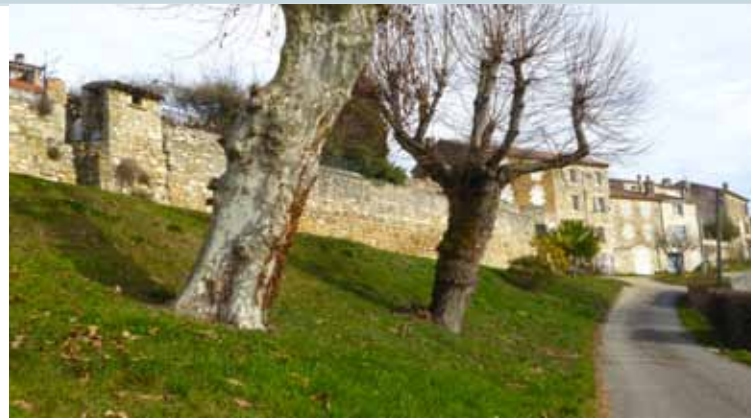
Les façades des maisons donnent encore à lire la ligne de remparts. La Sauvetat
