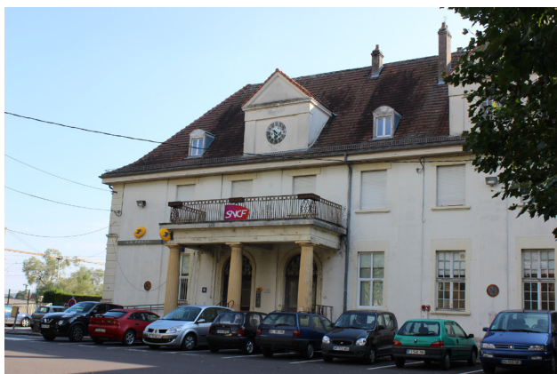
Les connexions autour des gares pour les trajets quotidiens sont à privilégier, renforcer, aménager et notamment pour les cyclistes (accès, stationnement).
