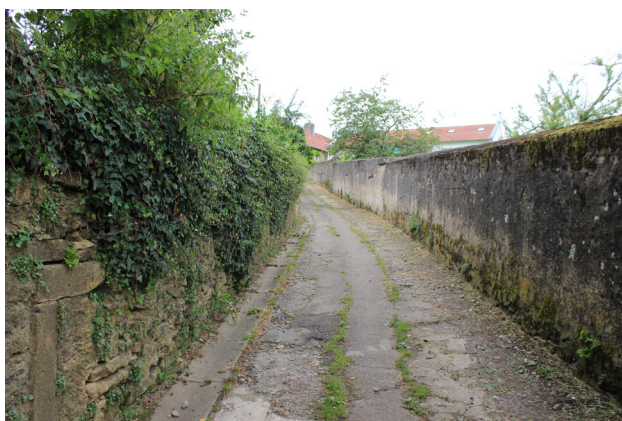
Les chemins qui permettent de lire les arrières du village sont connectés aux chemins qui traversent les tissus habités mettant ainsi en lumière le patrimoine bâti riche.
