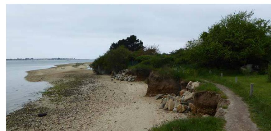
Riantec, Stervins, rue des pêcheurs. les défenses mises en place semblent renforcer les effets d'érosion à proximité.
