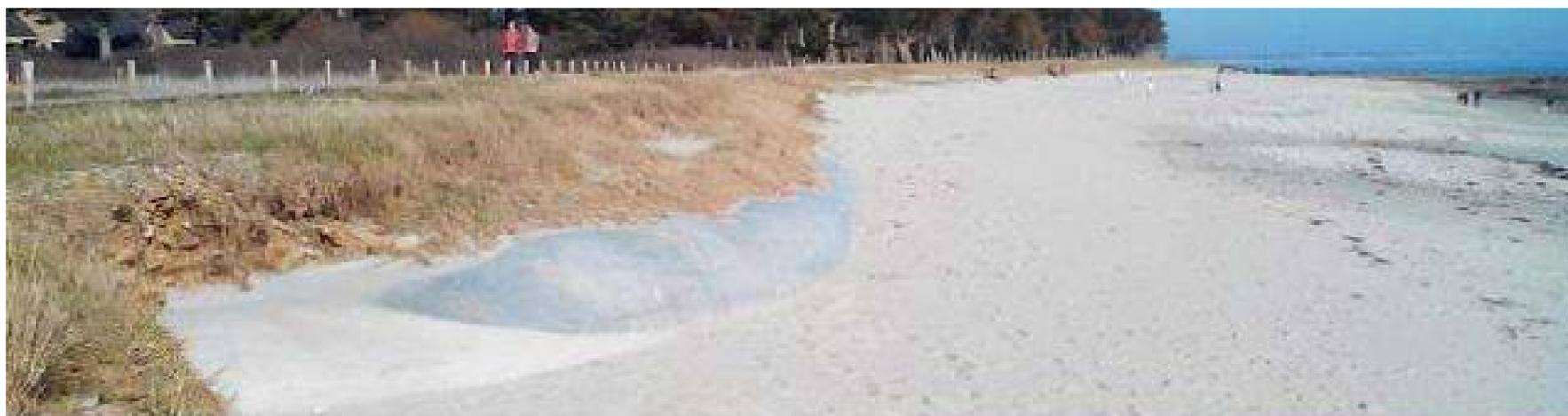
*Entre 2004 (photo en bas à gauche) et 2014 (en haut), la dune de Beg Lann (Ploemeur) sur laquelle des brèches étaient visibles a résisté aux assauts des tempêtes et n'a pas bougé. En 2007 (en bas à droite), trois ans après les travaux, le Stabiplage était, par endroit, recouvert par le sable et la dune revégétalisée. | Espace pur. Source : Ouest France publié le 04/12/2014*
