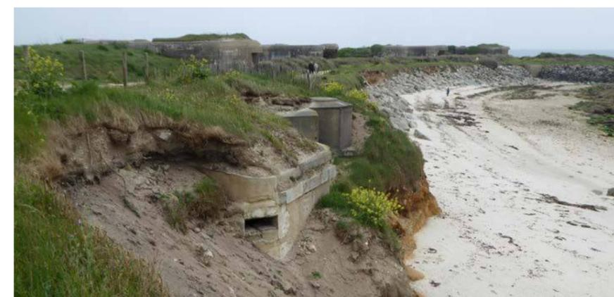
Gâvres, chemin des Saisies. L'érosion est sensible avec les bunkers peu à peu écroulés sur la plage... et avec les empierrements au second plan.
