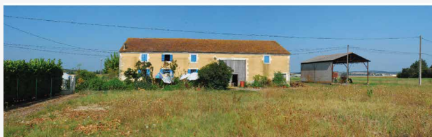
1 - Volumes bâtis pouvant servir de référence pour la construction de nouveaux logements collectifs.
