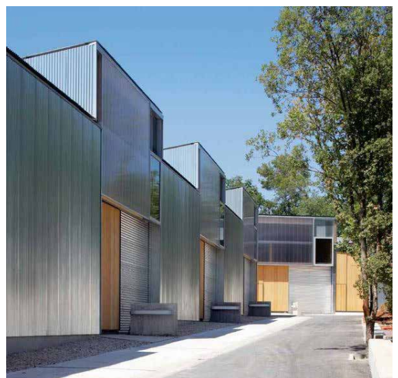
Cité artisanale de Valbonne - Architectes : Comte et Vollenweider
