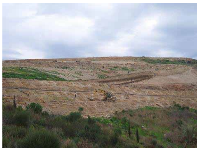
Travaux de consolidation des sols (fascines) pour la revégétalisation de la décharge de la Glacière (source : ONF)
