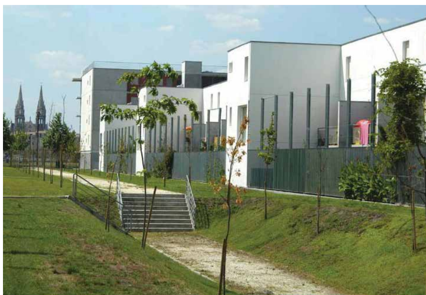
Intégration de bassins d'orage dans les jardins d'une zone résidentielle à Bordeaux
