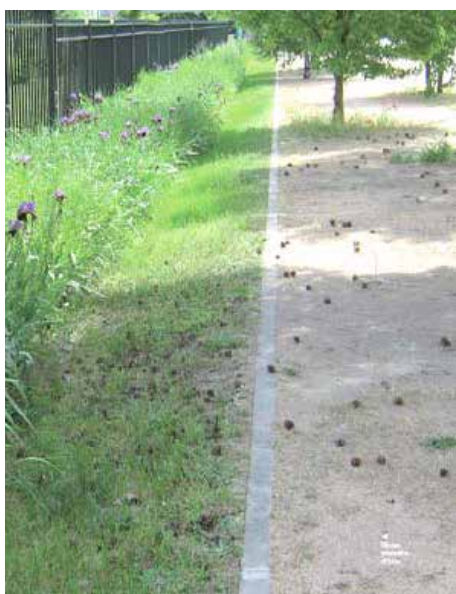
Exemple d'espace public intégrant des dispositifs de gestion des eaux pluviales : noue plantée d'iris et revêtements poreux
