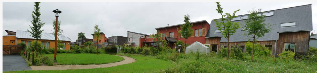
Bazouges-sous-Hédé (35) - Un éco-lotissement s'insérant dans le tissu de bourg et offrant des espaces publics généreux
