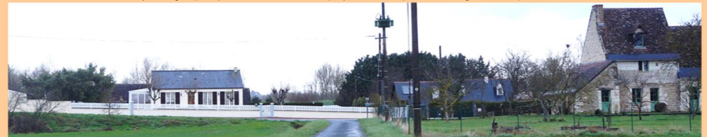
A EVITER : Clôture en plastique sur mur bahut en enduit claire sur une grande longueur.
