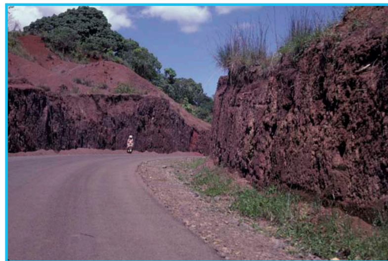
Passage en déblai de la RN 1/2 au niveau de la pointe Mahabou Source : Atelier Mahorais d'Architecture
