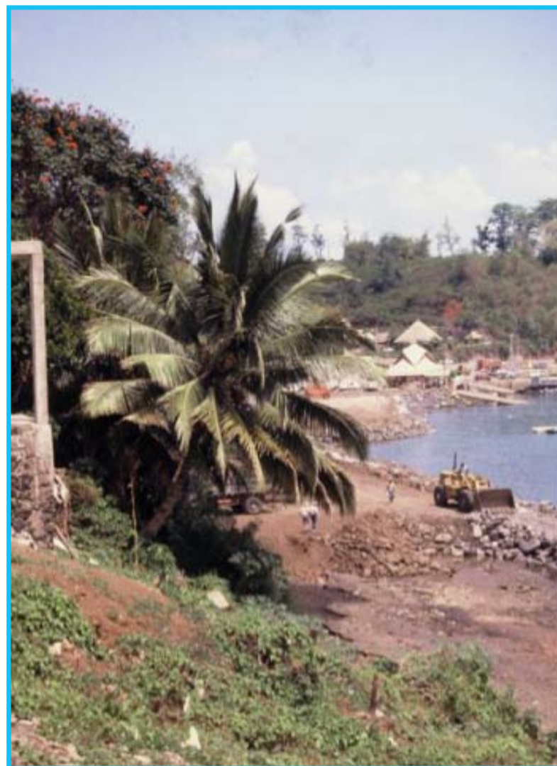
Rocade de Mamoudzou en chantier- Source : Atelier Mahorais d'Architecture
