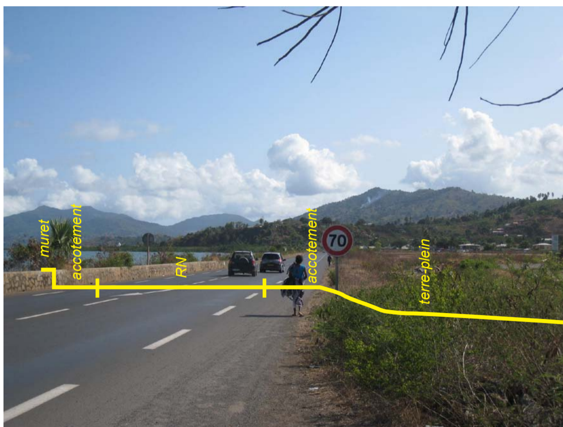
Profil de la séquence du terre-plein de Mtsapéré - Direction Tsoundzou 1
