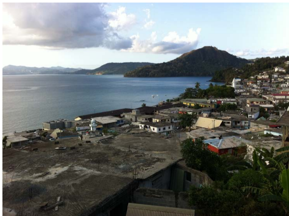
Des fers à béton et une toiture terrasse en attente d'un futur étage
