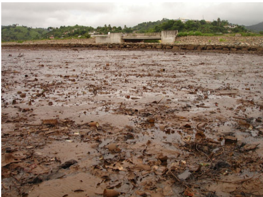
Rocade de Mtsapéré et enrochements sur l'estran
