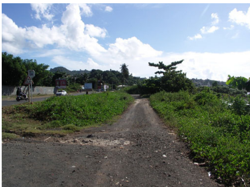
Végétation dégradée de l'arrière-mangrove et du haut de plage près du rond-point de Doujani suite à la création d'une piste de chantier en contre-allée de la RN2
