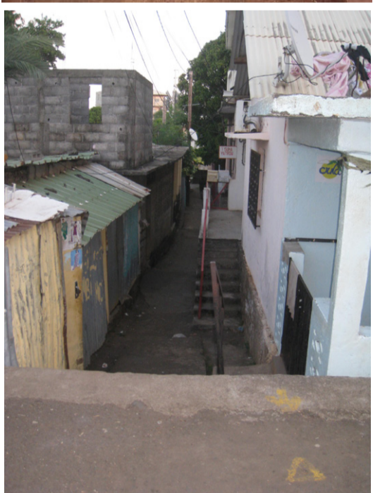
Maillage piéton riche : escalier, ruelle, venelle ...
