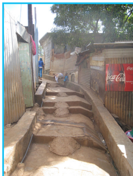
Difficulté de faire passer les réseaux d'assainissement dans ces quartiers souvent denses
