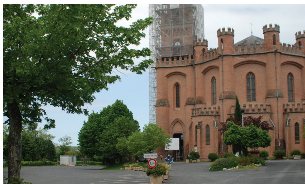
Les larges surfaces bitumées de l'accueil de ND de la Drèche banalisent l'espace et ne contribuent pas à valoriser le patrimoine architectural et la qualité d'accueil
