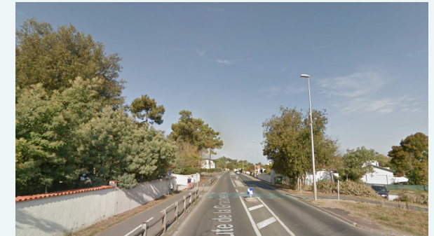
Exemple négatif / Saint-Trojan / Streetview Paysage / Vocabulaire routier / Limites marquées par des murs imperméables à la vue / paysage uniformisé Corridors biologiques / TVB / Murs imperméables ne laissant pas passer la biodiversité, axe accidentogène.
