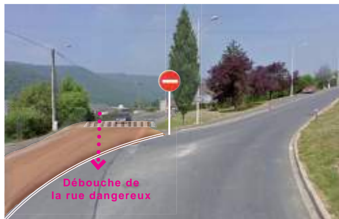
Carrefour rue Saint-Louis / rue de l'espérance Marquage du seuil de la rue résidentielle
