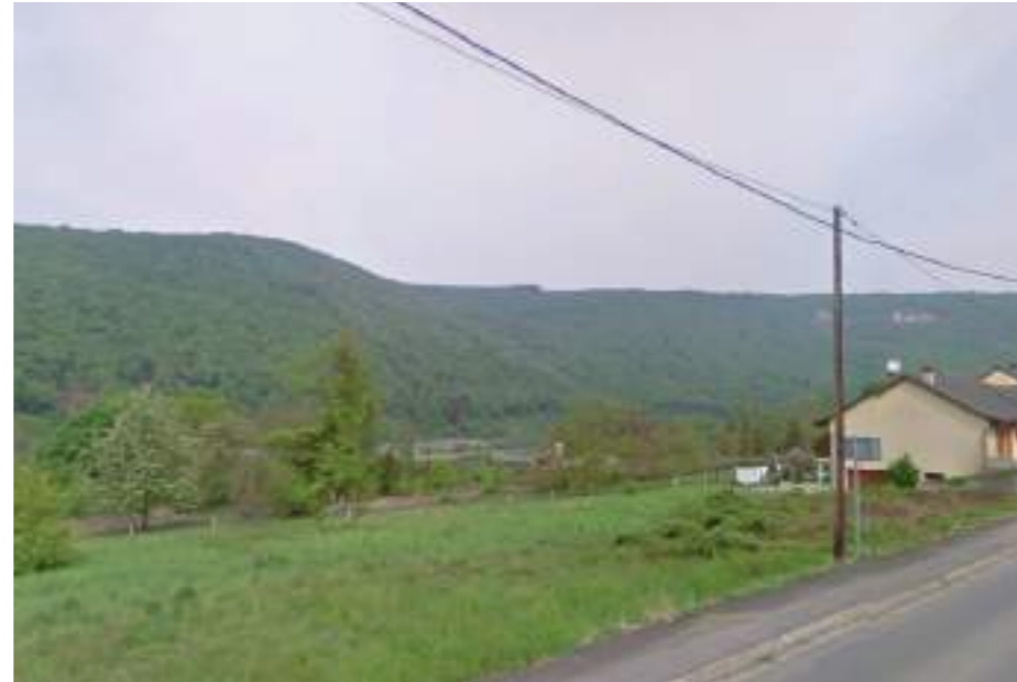
Fenêtre paysagère et coupures vertes valorisent la séquence urbaine et le cadre de vie des habitants.
