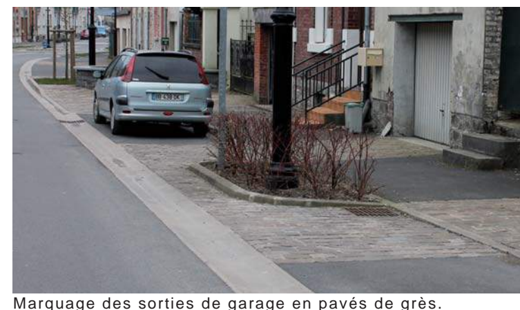
Marquage des sorties de garage en pavés de grès.
