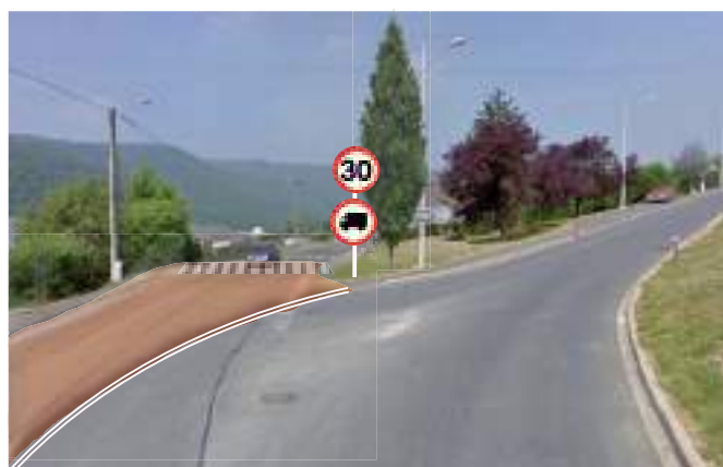
Carrefour rue Saint-Louis / rue de l'espérance Marquage du seuil avec une résine colorée gravillonnée (pas de plateau)
