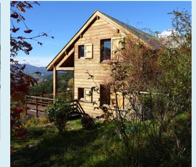
Le bois est un matériau adapté au site. Il se prête à une expression architecturale contemporaine.
