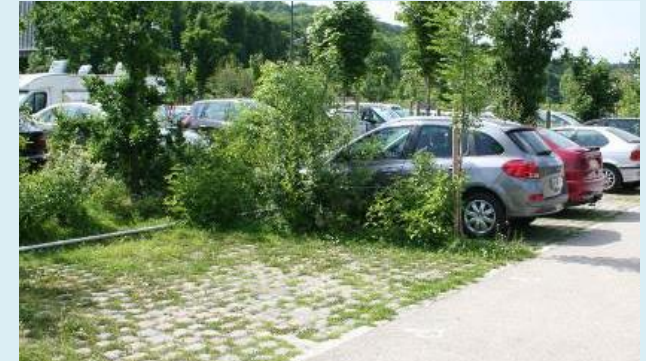
Espace de stationnement en pavés et joints enherbés
