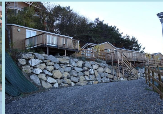
Des terrassements importants qui bouleversent la topographie, une artificialisation des sols trop importante qui peut créer des îlots de chaleur vu le manque de végétation arborée
