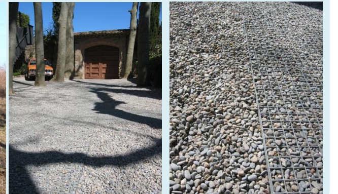
Chemin en caillebotis métallique
