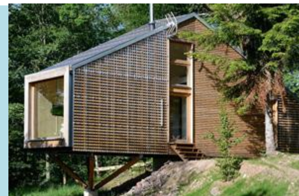
Vagney 88. Camping intercommunal, forme inspirée de l'architecture locale, en bois, avec une implantation très respectueuse du site
