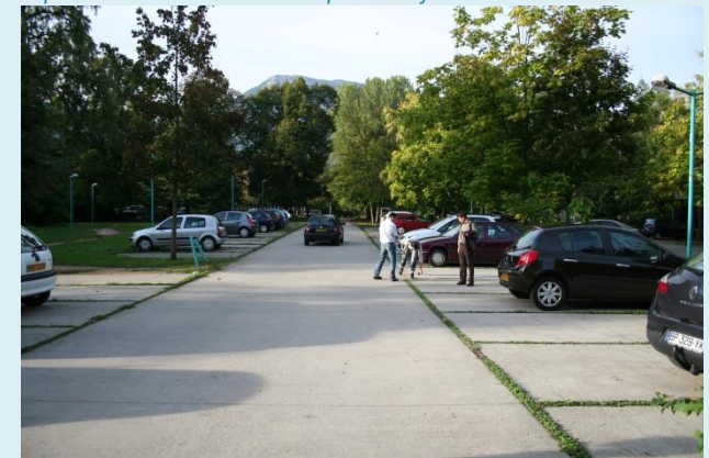
Espace de stationnement en béton et joints enherbés
