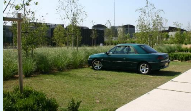
Espace de stationnement en dalles alvéolées enherbées
