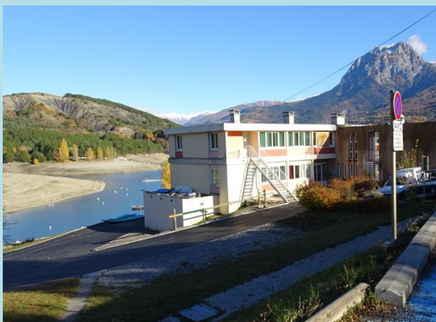
Les grandes étendues d'enrobé donnent un aspect ingrat et routier qui n'invitent pas à la déambulation
