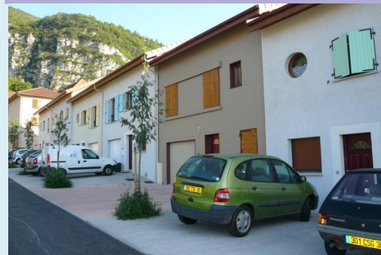
Source CAUE Isère
