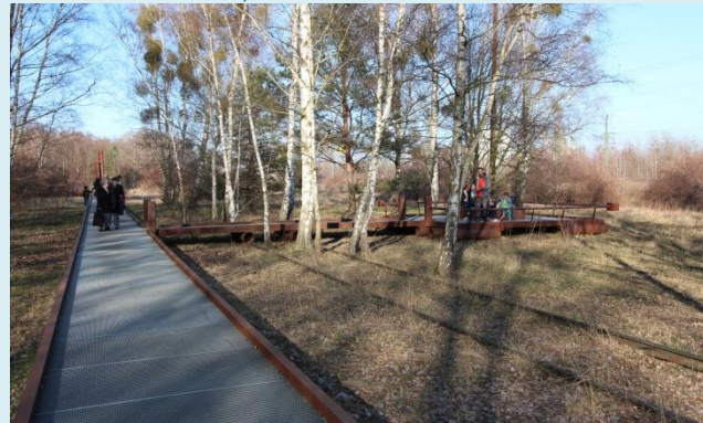
Chemin en caillebotis métallique
