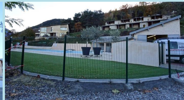
Clôture de type industriel, efficace mais dénuée de qualité esthétique
