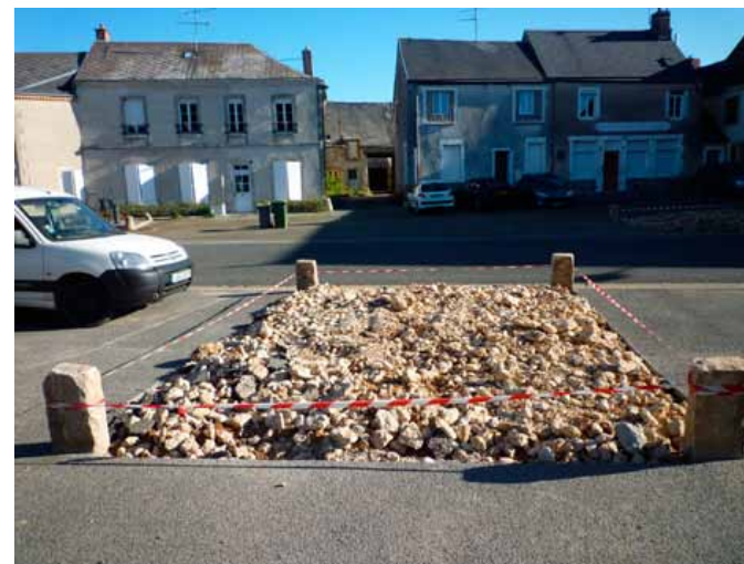
Tillay-le-Péneux : les matériaux de démolition apparents, lors du terrassement pour la plantation.
