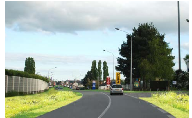
Principe n° 2 : De l'herbe, oui, mais économique dans sa gestion ; la largeur d'emprise de clôture à clôture est à considérer entièrement comme un tapis vert.
