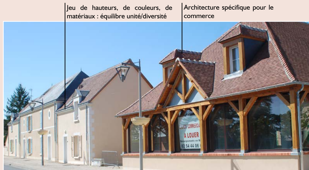
Candé-sur-Beuvron - Un effort dans l'inscription architecturale des nouveaux projets de construction dans un registre d'architecture classique
