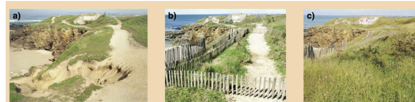
Figure 3.12. Côte rocheuse du fort du Loc'h (segment n° 21). (a) Mai 2000: ravine d'érosion entaillant le rebord de la côte rocheuse provoquée par l'évacuation des eaux pluviales collectées sur des surfaces imperméables; (b) avril 2006 et (c) février 2009: érosion continentale maîtrisée (tunage, ganivelles, gestion de la fréquentation) (© Erwan Le Cornec-Géos AEL).
