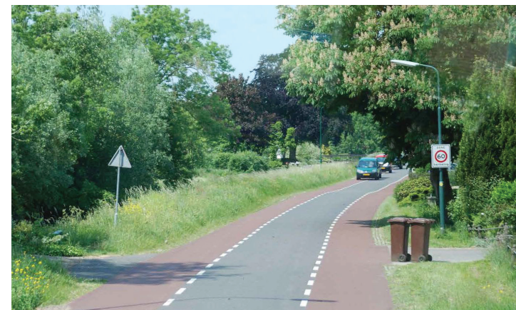
Exemple de voie partagée aux Pays Bas privilégiant les itinéraires doux : la route est à double sens automobile mais le marquage au sol indique la priorité aux vélos
