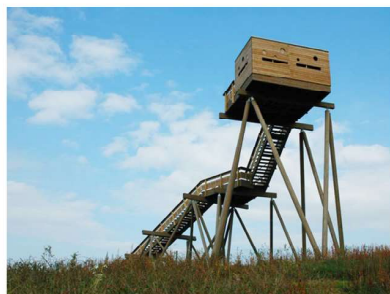
Belvédère-parc à Pessac (33)
