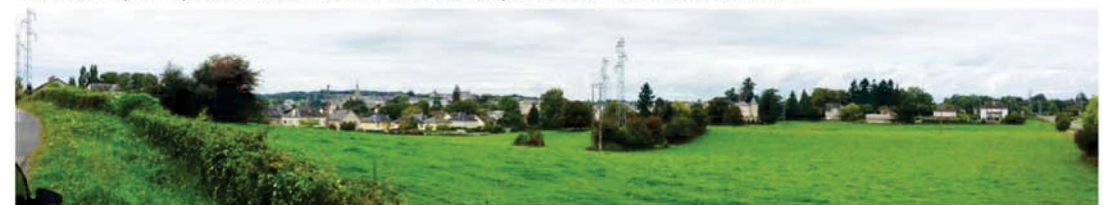
Limite urbaine de la Souterraine au Sud-Est, au niveau de la RD 912
