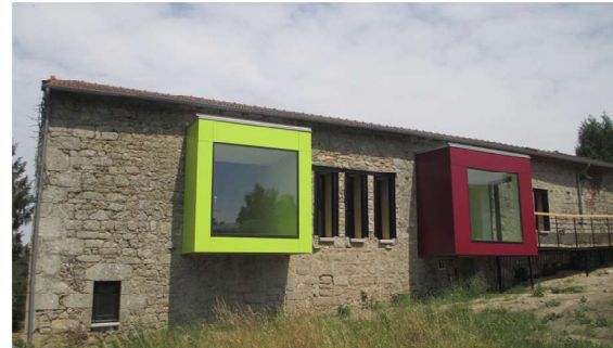
La grange des Ciatons à Ahun : réhabilitation d'une grange en micro-crèche (2015)
