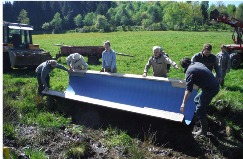
Chantier participatif organisé par le CEN Limousin, mai 2014 : Pose d'un système de franchissement de cours d'eau avec arche en PEHD surmontée d'un remblai, GAEC Rivière à Lestard (19)
