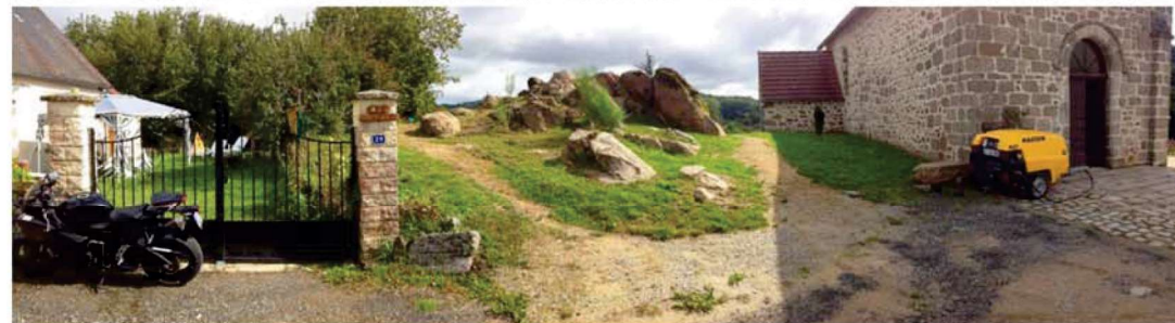
Butte de l'église rénovée, enrochements et plantations en limite des habitats privés
