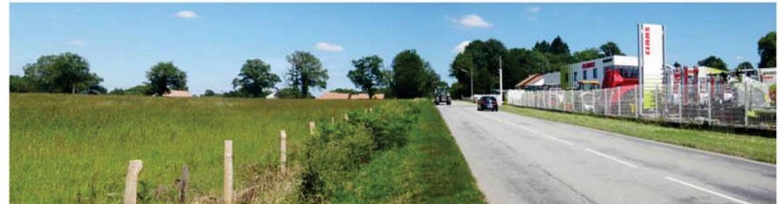
La RD 951, en limite Nord de la sous-entité : une structure hésitant entre la voie de zone d'activité et la route de campagne
