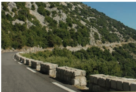
Parapets patrimoniaux typiques de de la Route Napoléon et autres routes du Pnr
