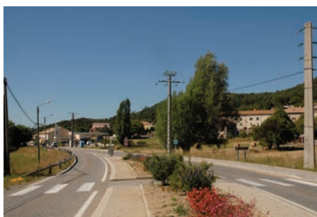
Terre-plein au Logis du Pin, aménagé pour des raisons de sécurité mais reflétant un
