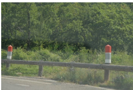
Glissières sécurité en bois en milieu plus forestier, plus adapté que la pierre
