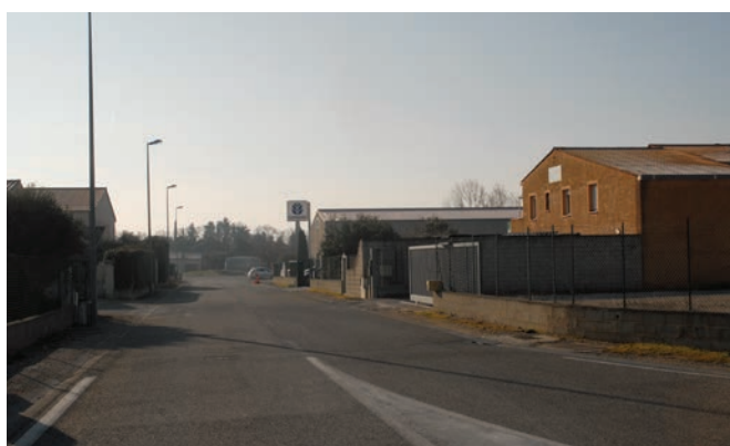
Aménagements, matériaux et mobilier trop urbains et/ou banals
