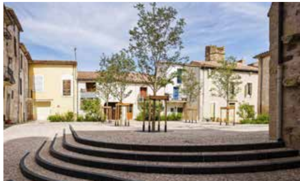
Place de l'église dans le centre-bourg de Montblanc — Hérault
