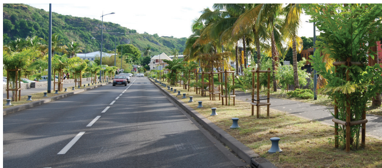
La Chaussée Royale à Saint-Paul (Ile de la Réunion) : avant travaux et après travaux
