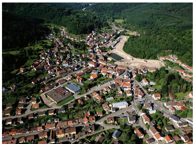
Site industriel textile Steinheil - pendant travaux - Rothau. Photo communauté de communes de la vallée de la Bruche
