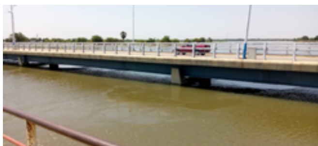
Ouvrage de franchissement lors de la crue fluviale de 2022
